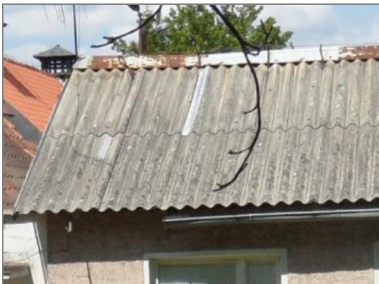
Fot.1 Płyty azbestowo-cementowe faliste
