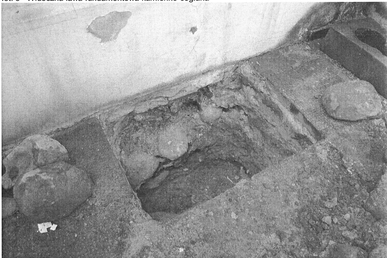
fot. 8 – Widoczna łąwa fundamentowa kamiennie-ceglana
