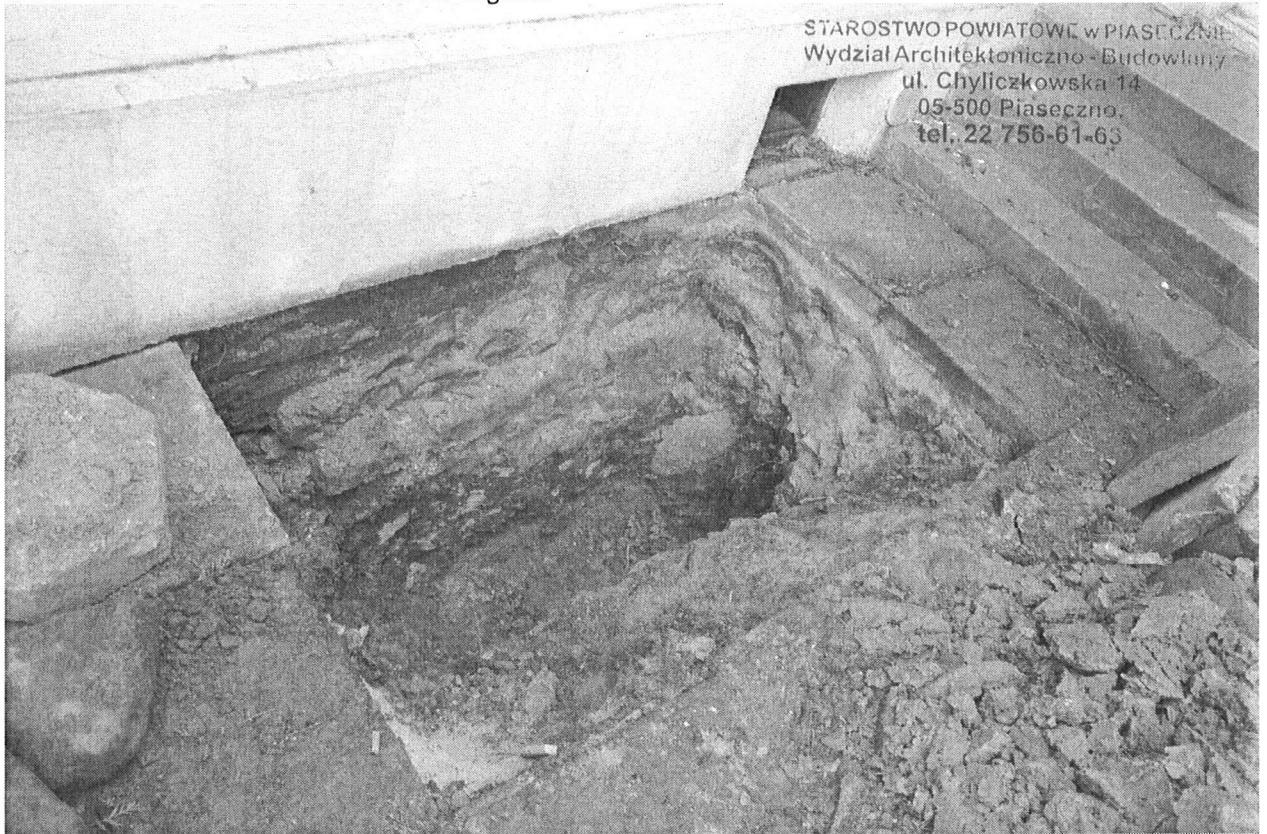
fol. 9- Widoczna 1awa fundamentowa ceglana
