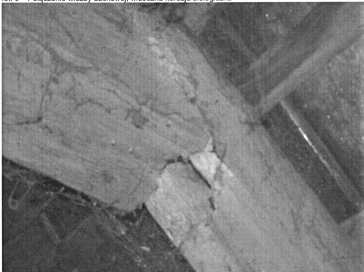
fot. 6 – Połączenie wieżby dachowej, widoczna korozja biologiczna
