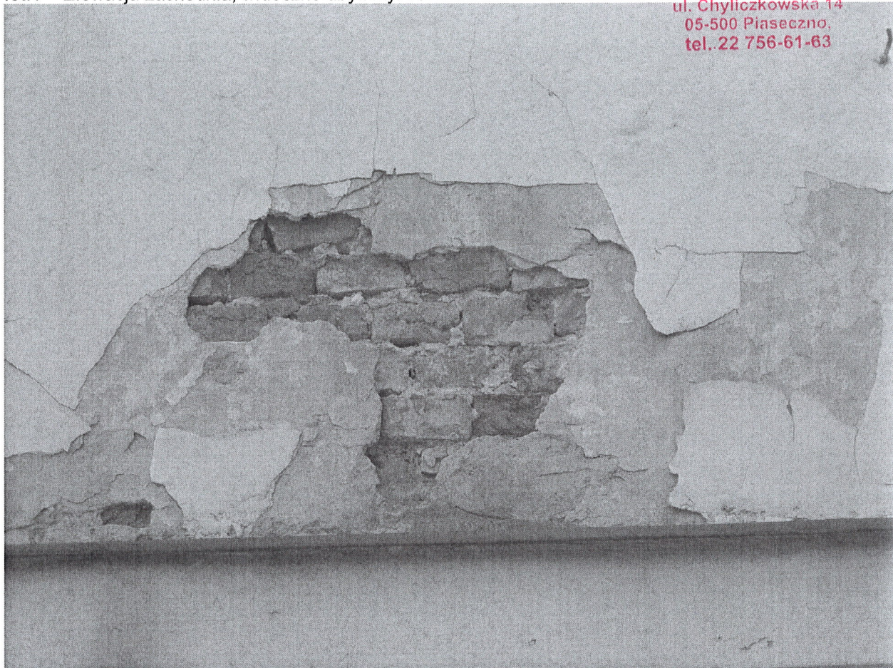
fot.2 – Elewacja północna, widoczne ubytki w elewacji
