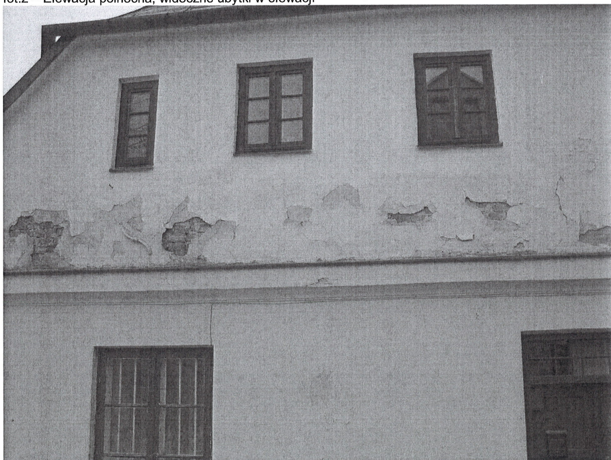
fot.2 – Elewacja północna, widoczne ubytki w elewacji
