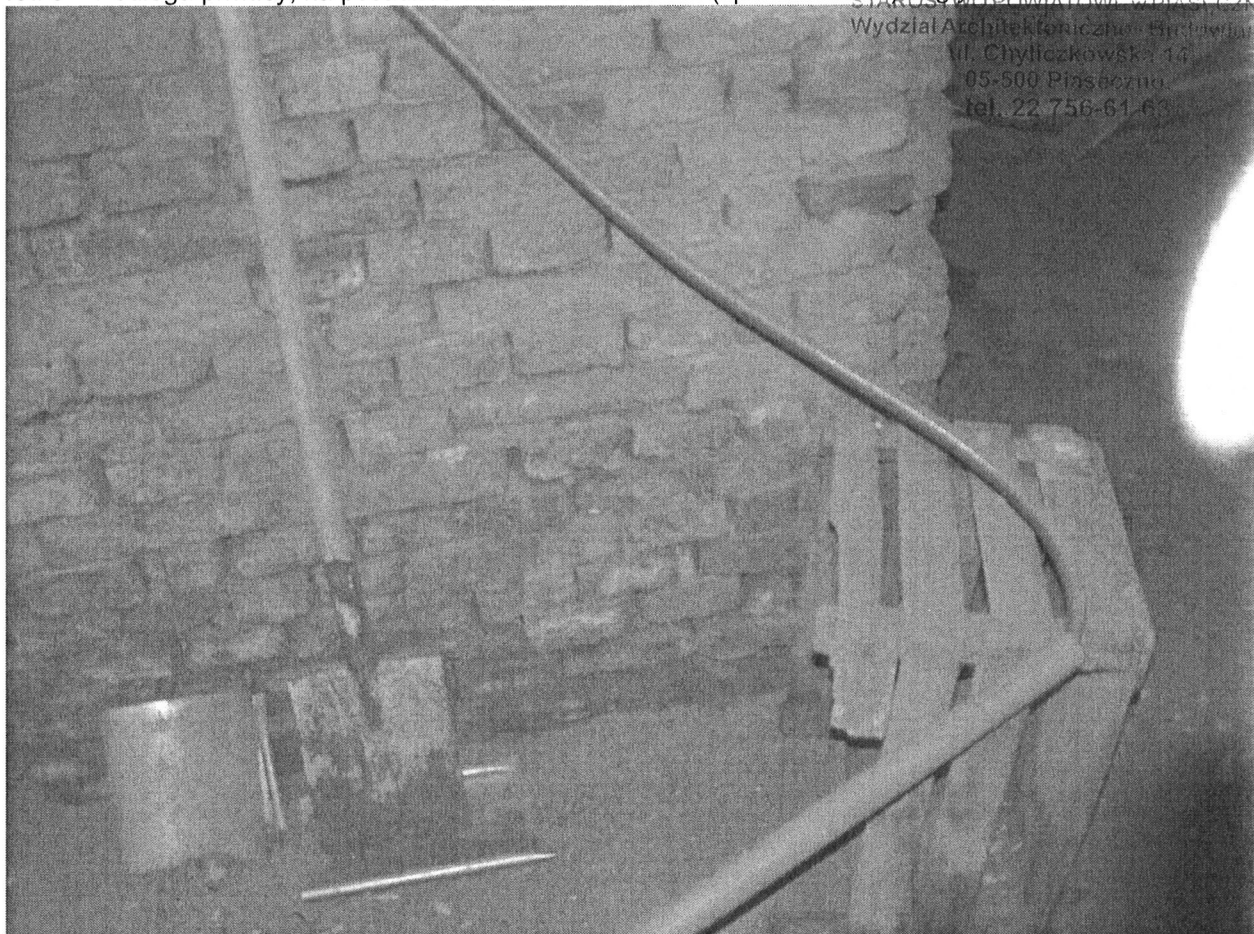
fot. 6 – Połączenie wieżby dachowej, widoczna korozja biologiczna
