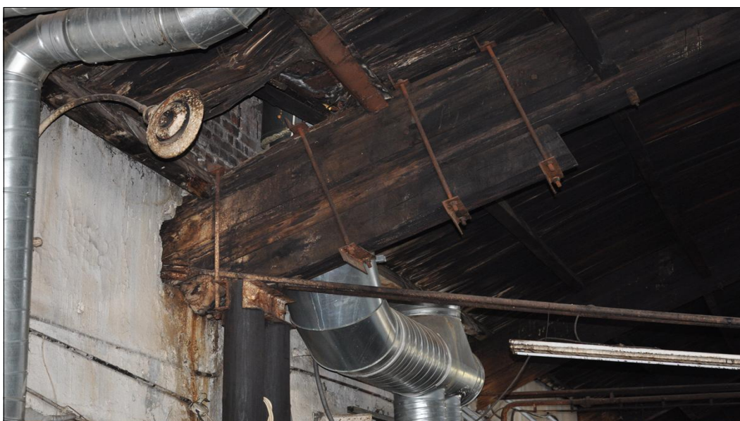
Fot. 12.7. Punkt oparcia łuków po zapiegach naprawczych.
