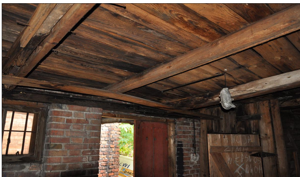
Fot. 5.4. Widok na zdegradowaną konstrukcję dachu.
