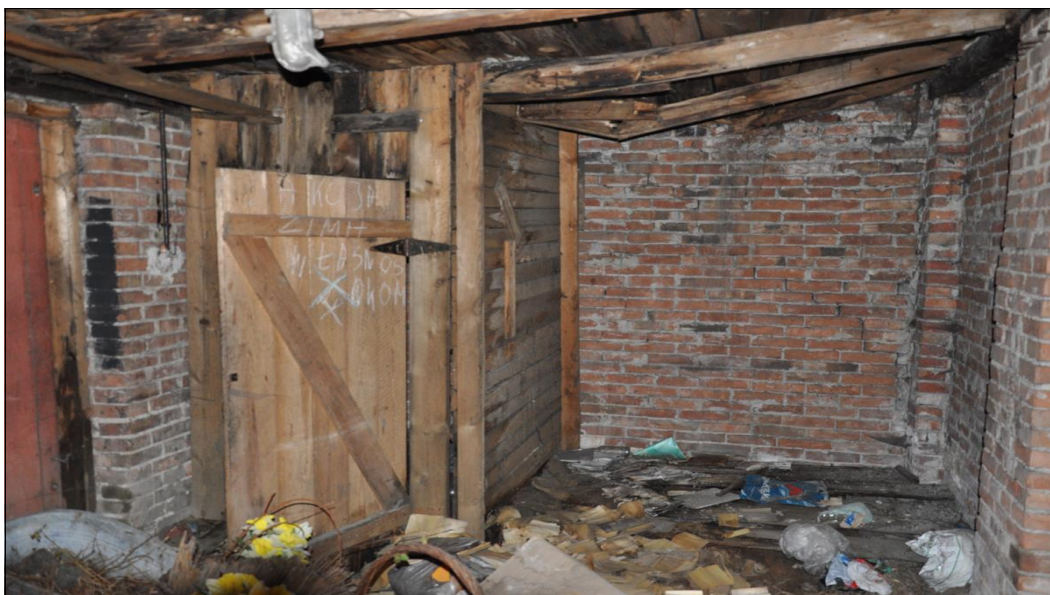
Fot. 5.3. Wnętrze komórki z uszkodzoną konstrukcją dachu.
