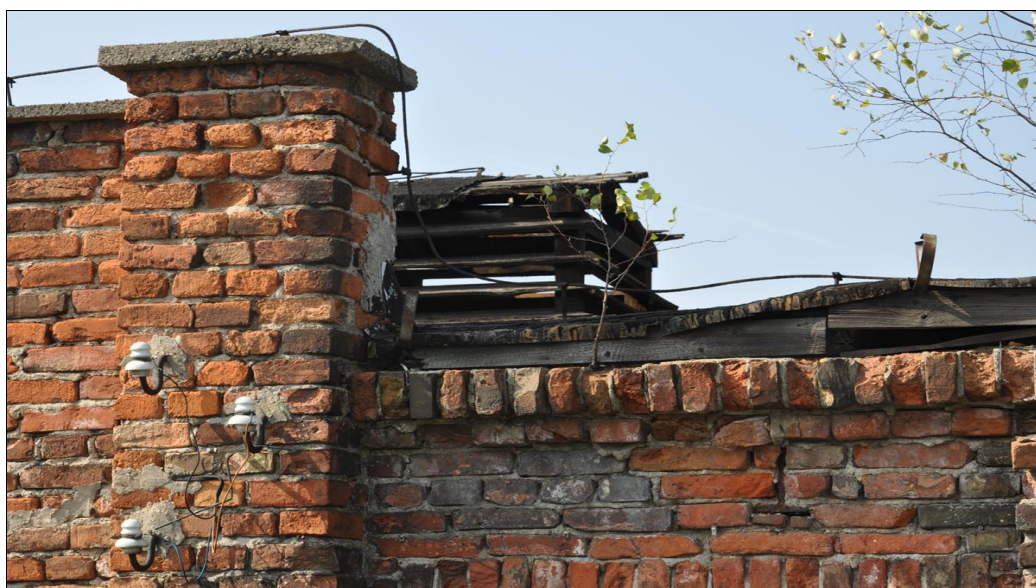
Fot. 8.6. Widok zdewastowany wywietrznik kalenicowy.
