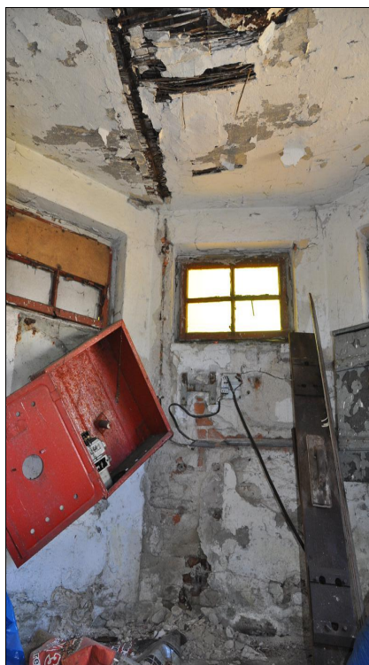
Fot. 13.5 i 13.6 Widok wnętrza pompowni (wyraźne ubytki tynku w podsufitce).
