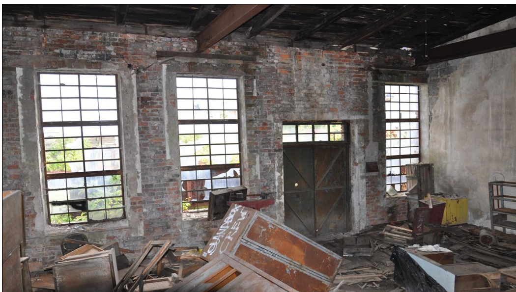
Fot. 9.7. Widok na wnętrze kuźni (widoczna dewastacja dachu).
