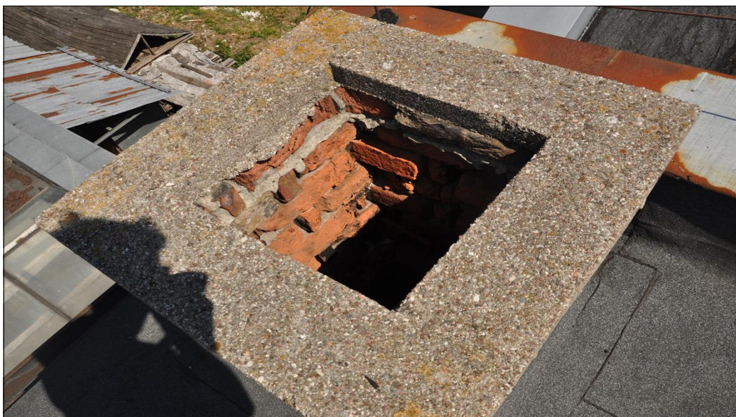
Fot. 3.5. Widok na komin dymowy w części północno-wschodniej (brak obróbek powoduje zawilgocenie ścian w pomieszczeniach na piętrze).
