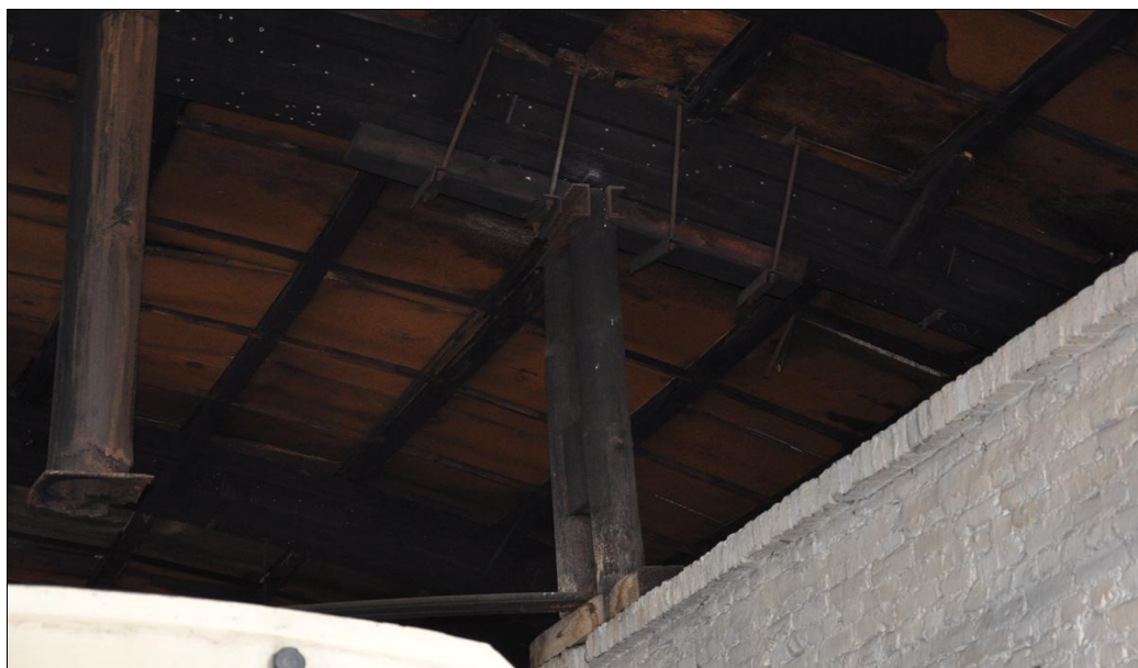
Fot. 12.8. Podparcie łuku konstrukcyjnego w ramach działań naprawczych.
