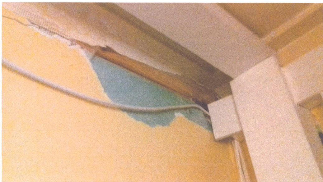
Zdjęcie nr 20 odkrywka nr 3, wewnątrz widoczna sucha zabudowa ścian i sufitu,
