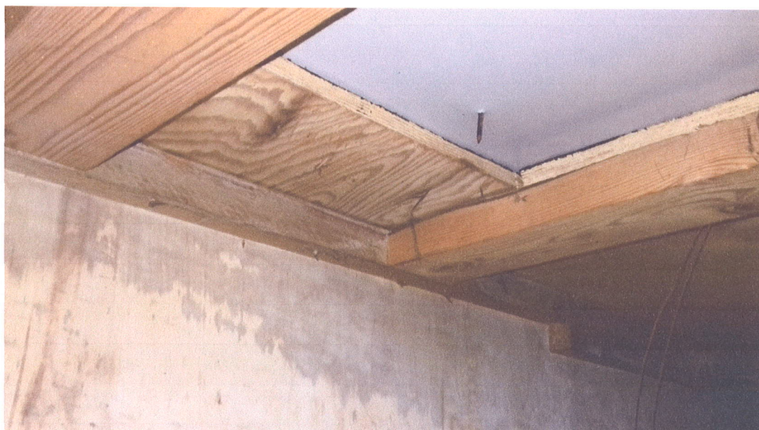
Zdjęcie nr 19, wewnątrz przestrzeni między dźwigarami, wycięcie w pokryciu dachu,
