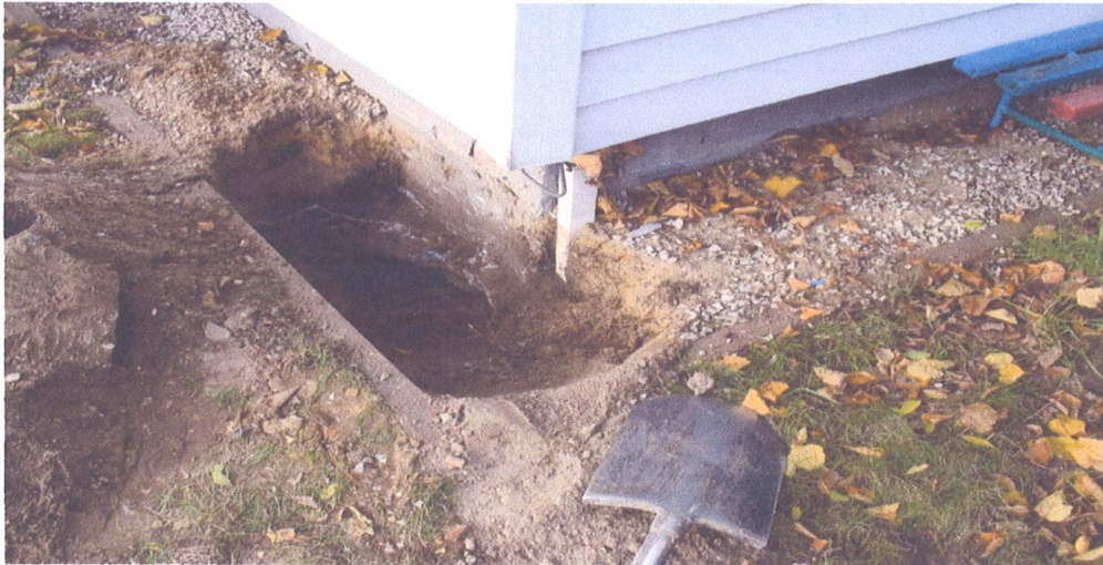
Zdjęcie nr 1, odkrywka nr 1 podwaliny od strony zachodniej, opaska posiada posypkę z kruszywa, poniżej jest to mieszanina mineralna,
