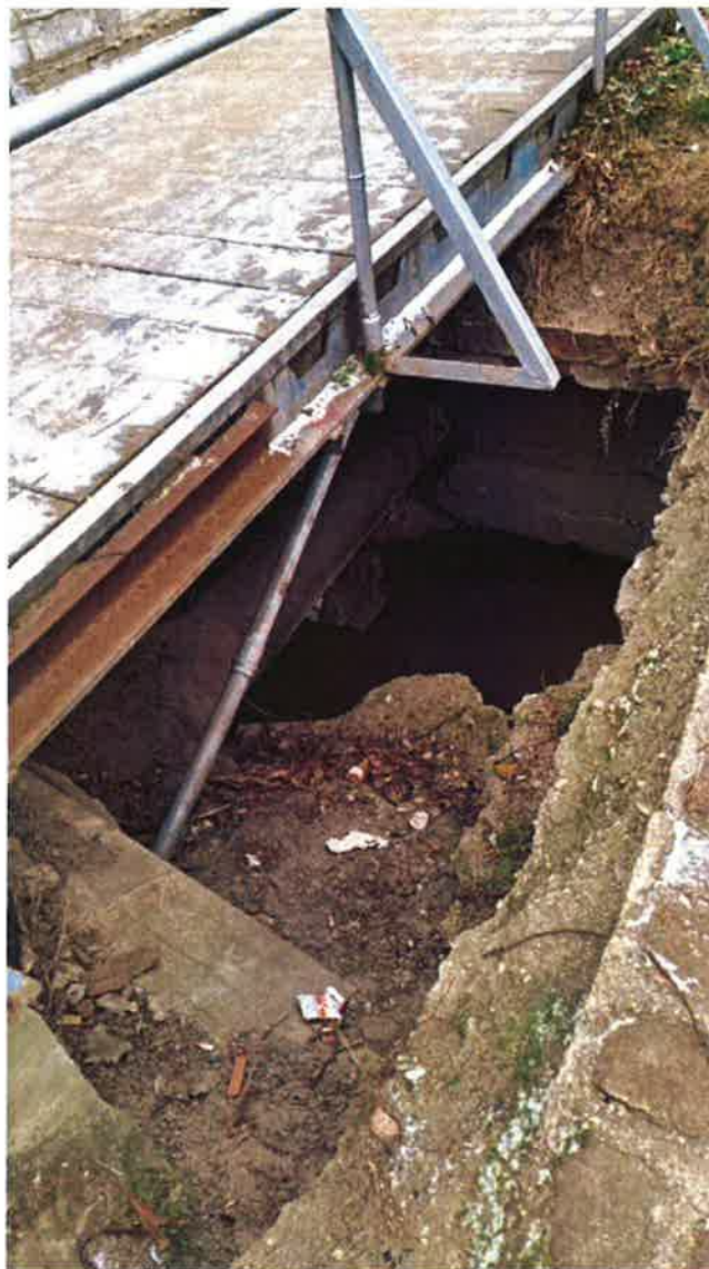
Fot. 6 Widok na wnętrze obiektu istniejącego i nieczynny wodociąg DN150.
