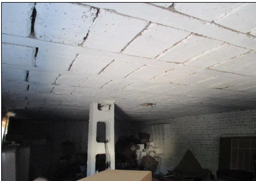
Fot. 11. Widok na strop gęstożebrowy w pom. nr 4, sekcja A.
