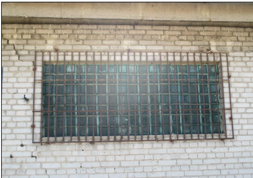
Fot. 23. Okno wypełnione luksferami i zabezpieczone kratą. Źródło pochodzenia fotografii: własne
