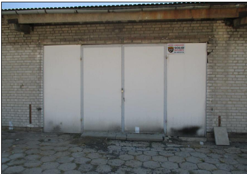
Fot. 22. Brama z płyt PW8. Źródło pochodzenia fotografii: własne
