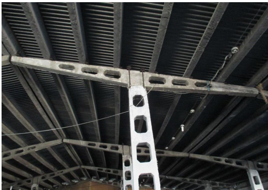
Fot. 15. Widok na strop i dźwigar oraz płatwie i pokrycie dachu.
