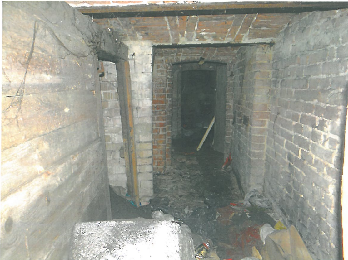
Rys.6. Wnętrze budynku – piwnica.
