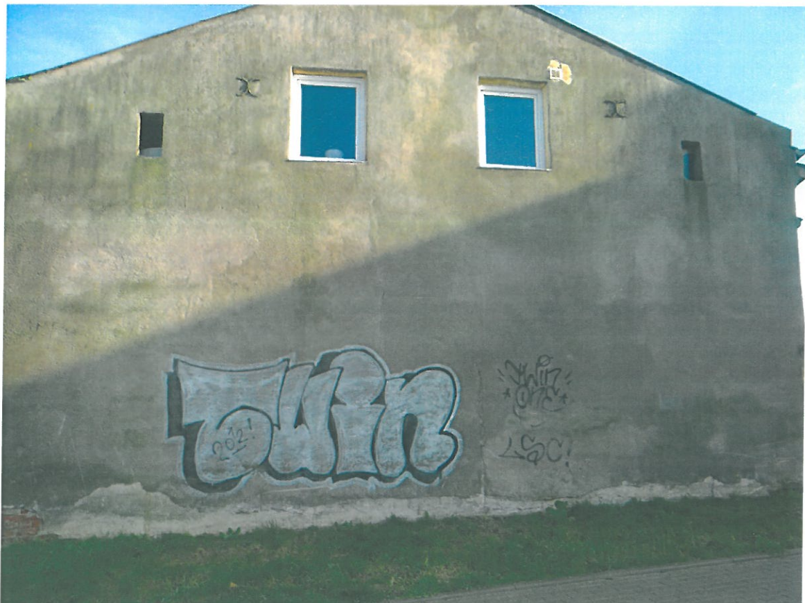
Rys.4. Widok elewacji zachodniej.
