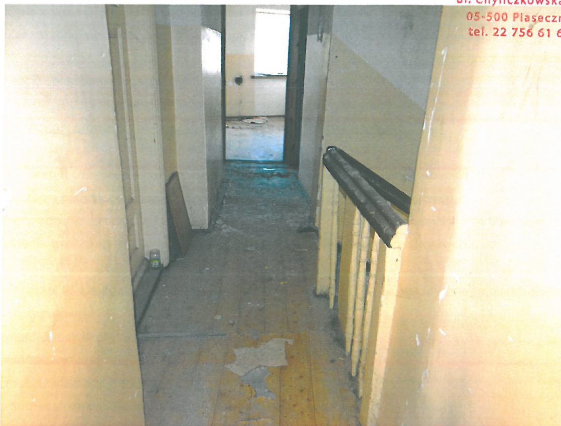
Rys.9. Wnętrze budynku – piętro.
