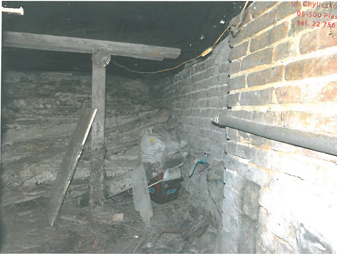
Rys.5. Wnętrze budynku – piwnica.
