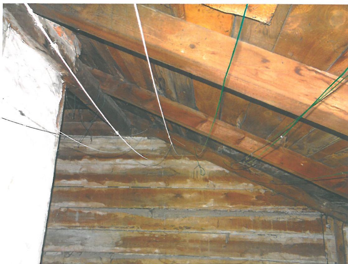
Rys.10. Widok więźby dachowej.
