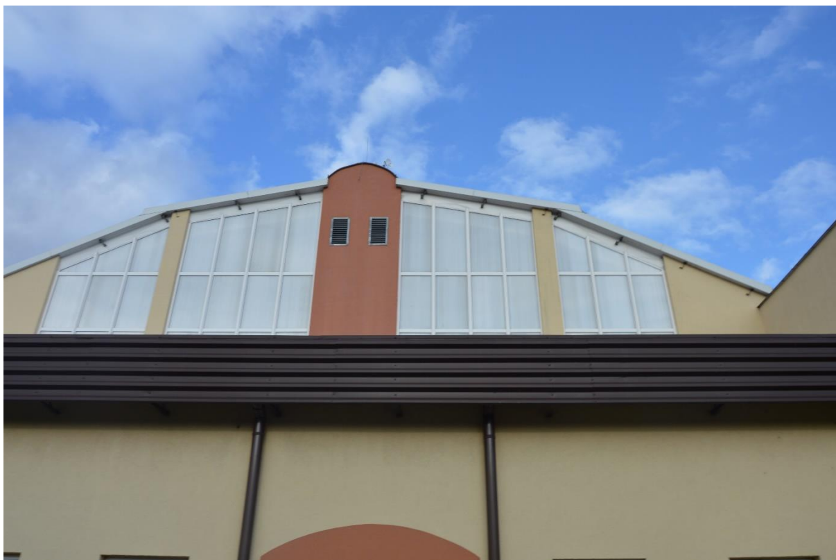
Zdjęcie nr 6. Widok na halę sportową od strony południowej, widoczne okna zostaną przebudowane w ramach rozbudowy szkoły.
