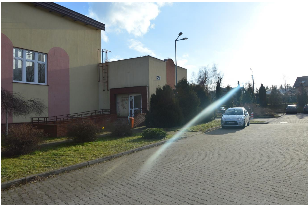
Zdjęcie nr 5. Widok na halę sportową i łącznik. W tle ul. Millenium.
