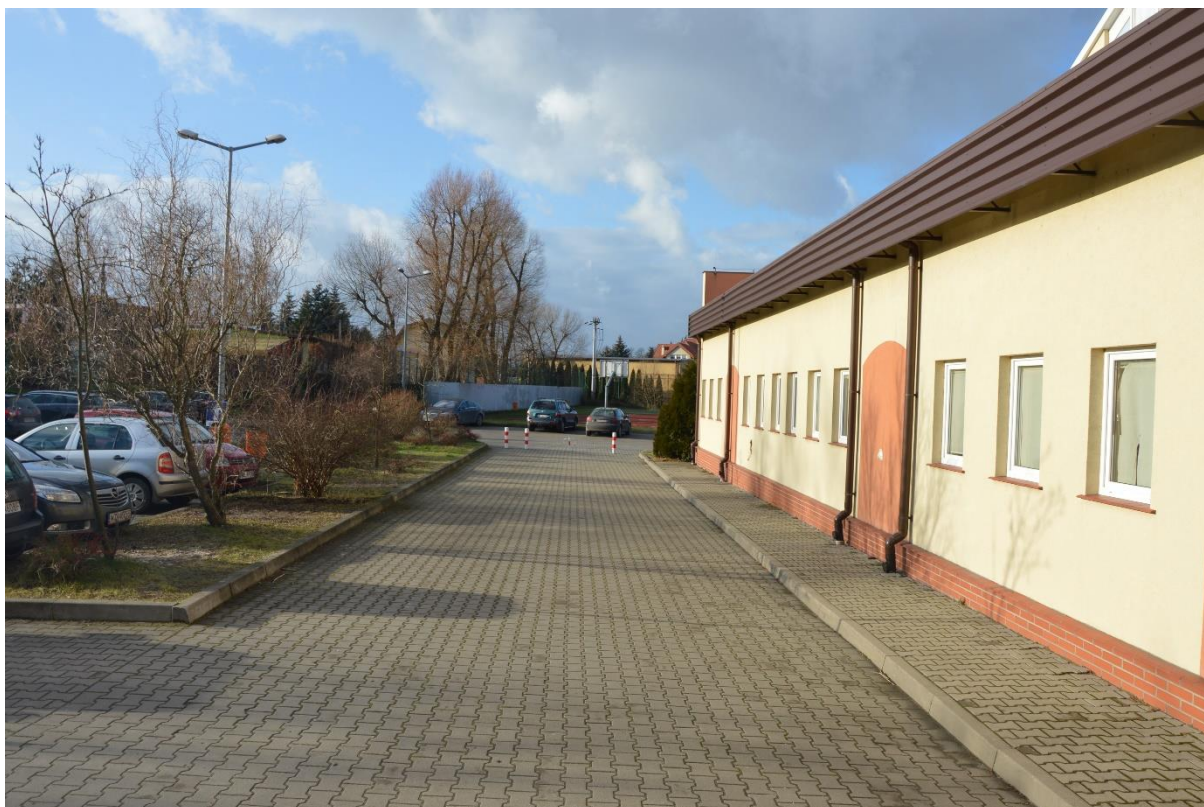
Zdjęcie nr 1. Widok na łącznik podlegający rozbiórce, roślinność do przesadzenia, rozbiórka fragmentu terenu utwardzonego.
