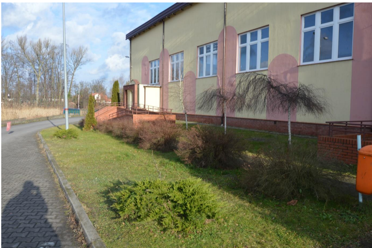
Zdjęcie nr 3. Widok na halę sportową, przy elewacji wschodniej zostanie rozbudowany budynek w poziomie parteru. Widok na drzewa i krzewy do przesadzenia.
