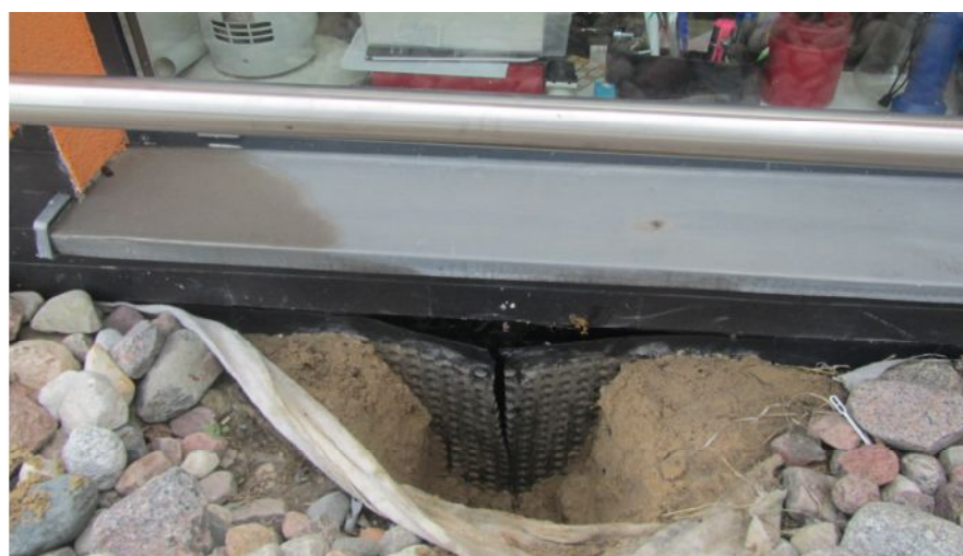
Fot. 9-10 Odkrywka od zewnątrz budynku tuż przy ścianie zewnętrznej. W odkrywce stwierdzono wykonanie zabezpieczenia ściany zgodnie z projektem i sztuką budowlaną
