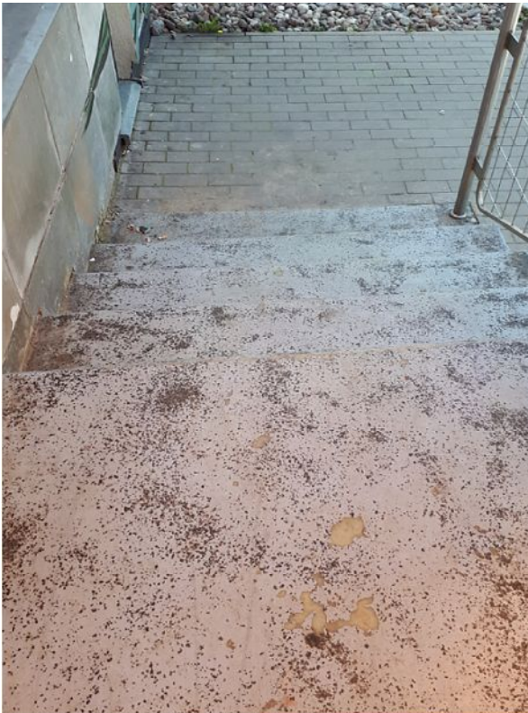
Fot. 18-19 Stan posadzki na schodach
