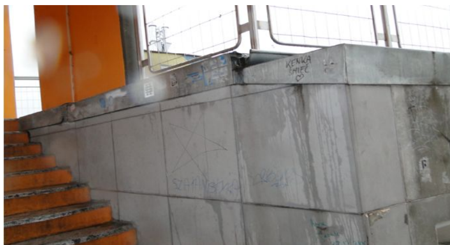
Fot. 34 Falująca nierówna linia okapnika tarasu, brak połączeń poszczególnych fragmentów blach okapnika powodują powstawanie zacieków na elewacjach
