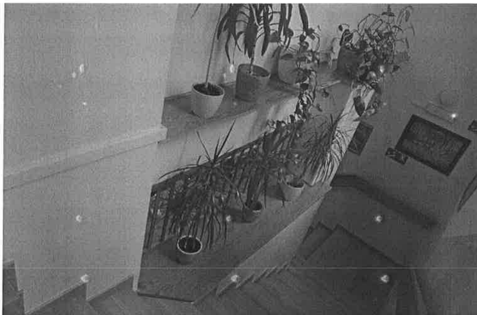
Fot. 4. Widok klatki schodowej prowadzącej na parter. Schody podlegają zabezpieczeniu, drewniane półki podlegają demontażowi.
