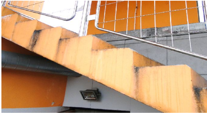
Fot. 25 Widok ogólny na schody prowadzące na taras. Pod schodami zlokalizowane są drzwi wejściowe do budynku od strony wschodniej. Na nadprożu nad drzwiami w czasie opadów deszczu pojawia się czynny zaciek wodny. Przeciek spowodowany jest wadliwym wykonawstwem koryta ściekowego zamontowanego na tarasie
