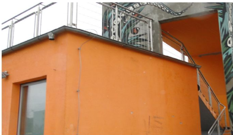
Fot. 39-40 Wadliwie wykonana wiatrownica zadaszzenia nad schodami ( pionowa obróbka blacharska odprowadzająca wodę z tarasu, powodują powstawanie zacieków na elewacjach
