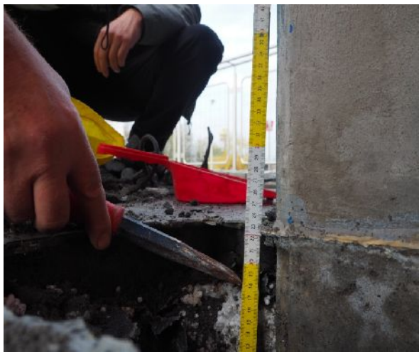
Fot. 49-53 | Odkrywka w warstwach tarasu, wykonana przy schodach
