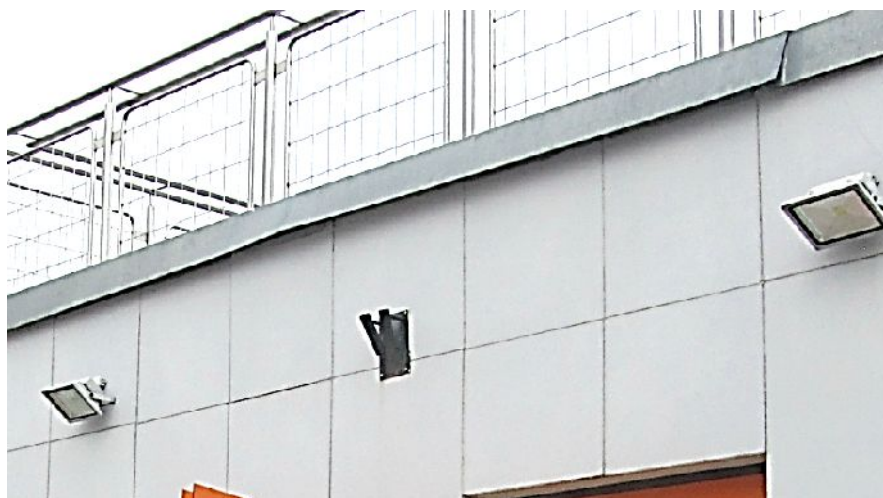
Fot. 34 Falująca nierówna linia okapnika tarasu, brak połączeń poszczególnych fragmentów blach okapnika powodują powstawanie zacieków na elewacjach
