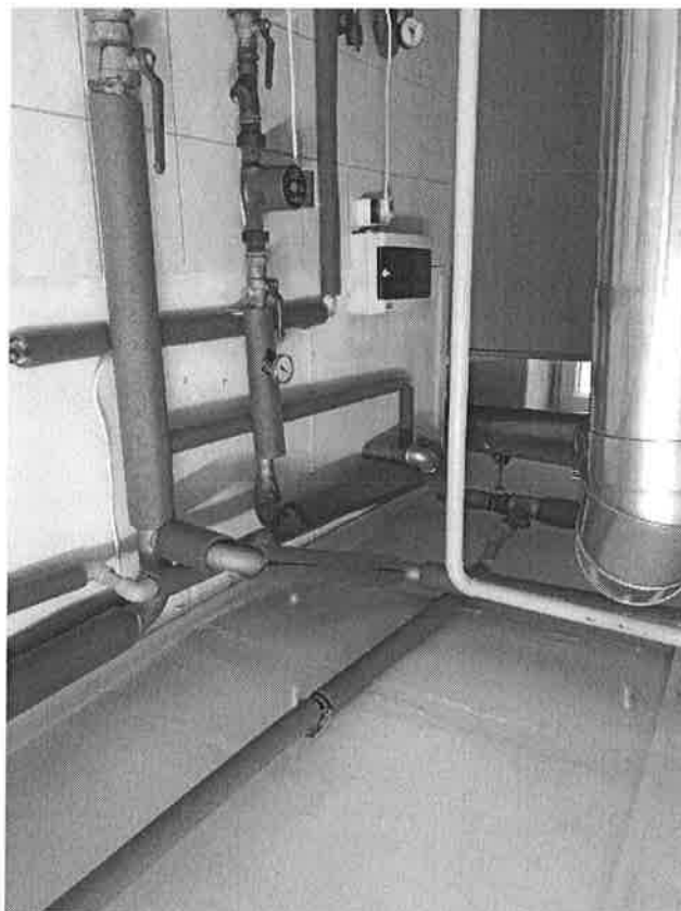
Fot. 2. Widok pomieszczenia kotłowni. Przejścia przez strefę pożarową instalacji sanitarnych podlegające zabezpieczeniu.
