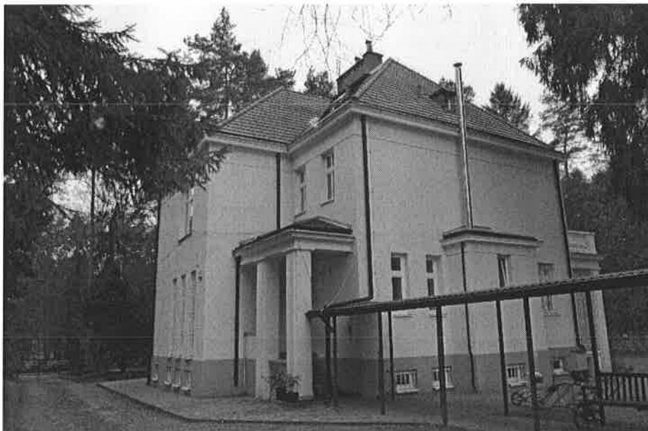
Fot. 1. Widok elewacji budynku – brak widocznych zarysowań ścian. Elewacja wyremontowana, pokrycie dachu dachówką ceramiczną karpiówką, okna i drzwi PCV.
