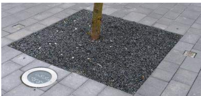
Typowe miejsce instalacji ArborVent.
