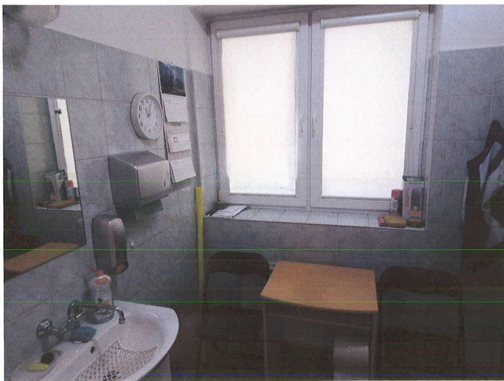
Poziom parteru, widok w stronę okna, miejsce wejścia do windy, drzwi windy zlokalizowano w świetle okna
