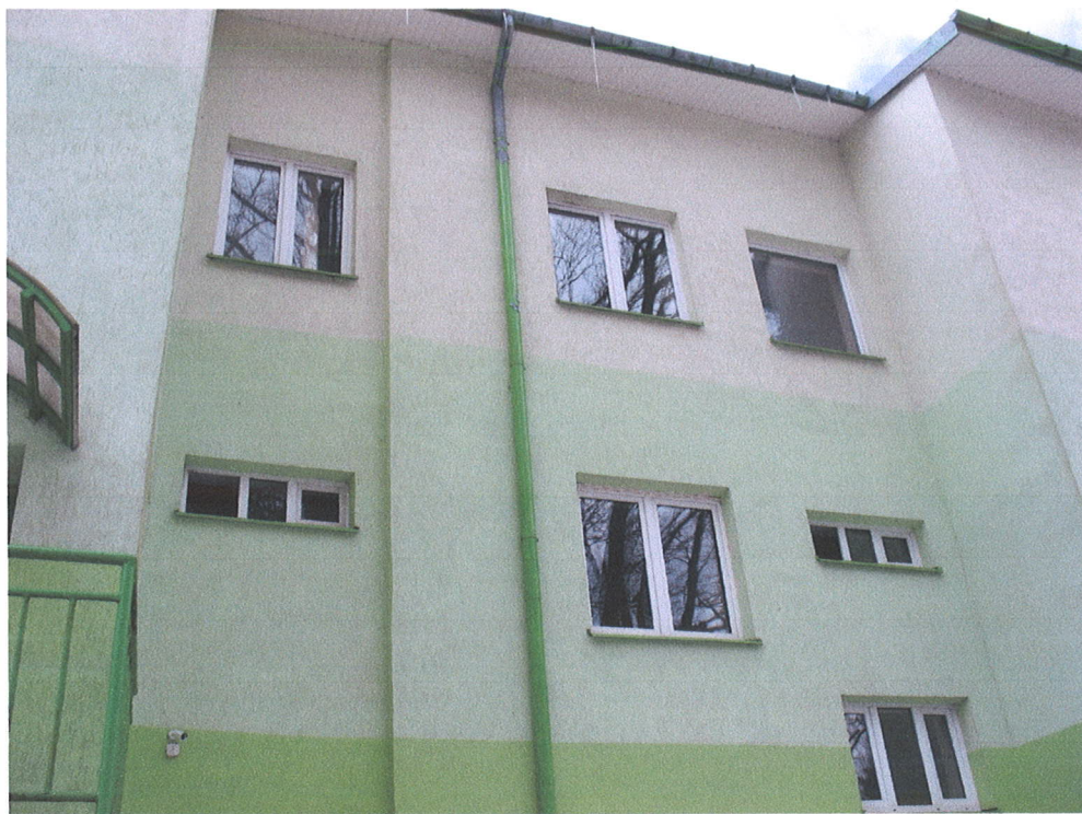
Elewacja wschodnia - widok ściany, do której dobudowany zostanie szyb windy
