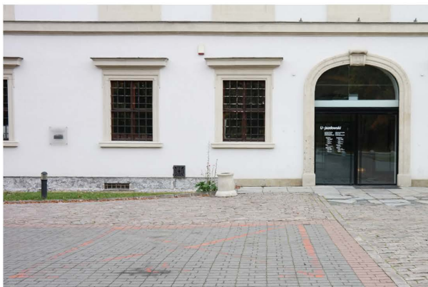
Stanowiska postojowe, które mogą być udostępnione osobom z niepełnosprawnościami, zlokalizowane blisko wejścia głównego
