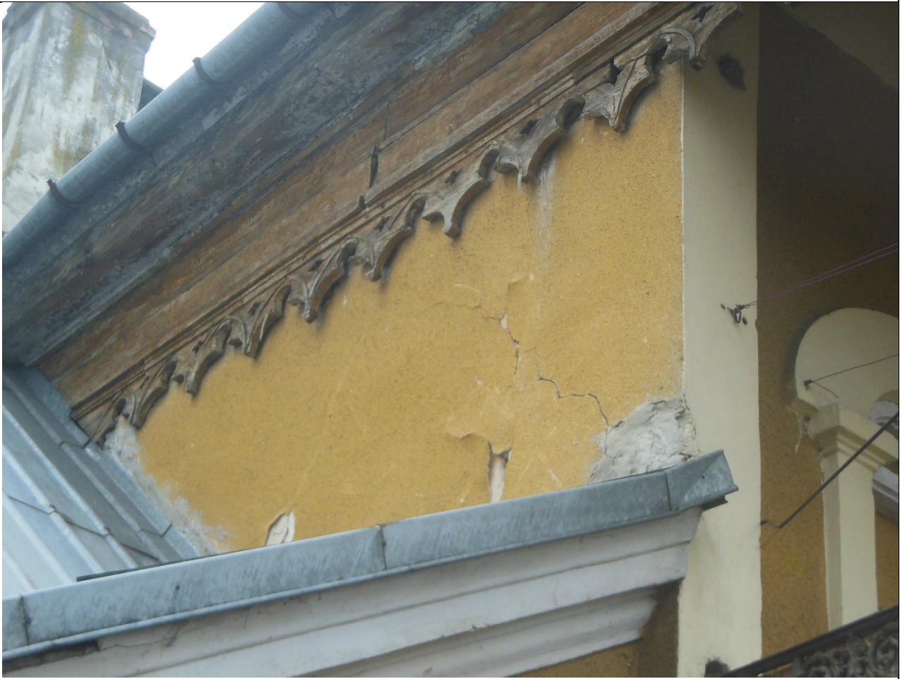
Rys. 19 – Detal wiatrownicy ganka
