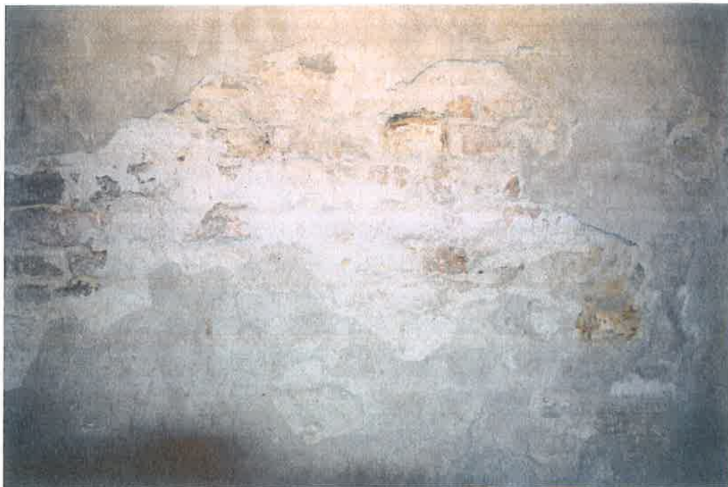
Zdjęcie nr 9 skanowanej ściany przy schodach do piwnicy.
