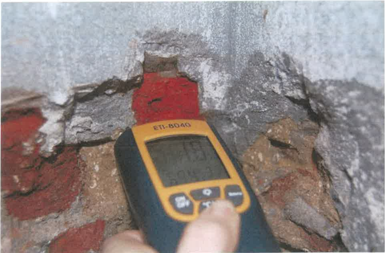
fot. 12. Stan cegieł piwnica.
