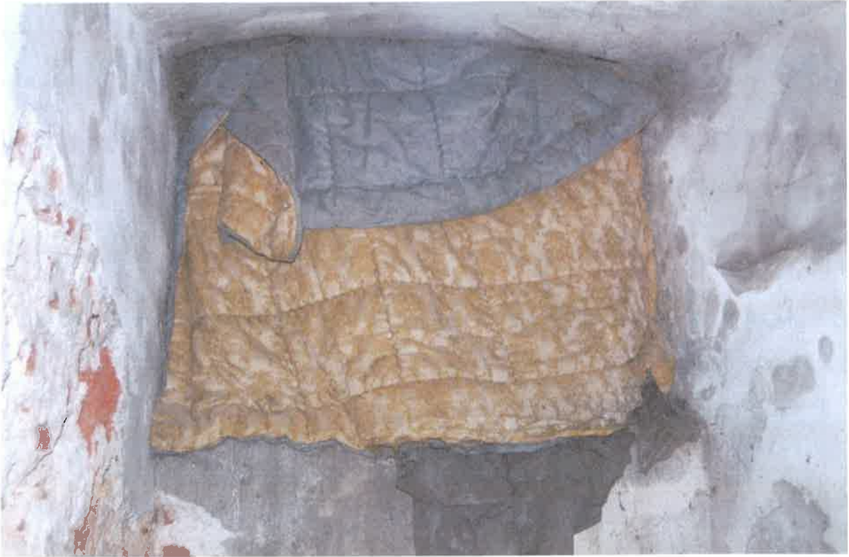
fot. 11. Otwór okienny zabezpieczony koldrą.
