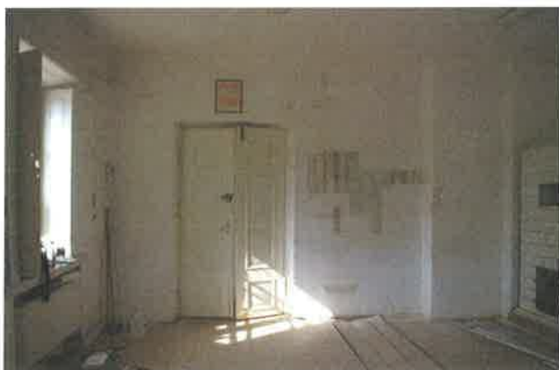
Ściana północna, widoczna odkrywka malowidła
