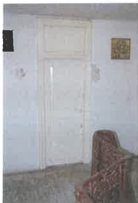
Drzwi prowadzące do pomieszczenia F
