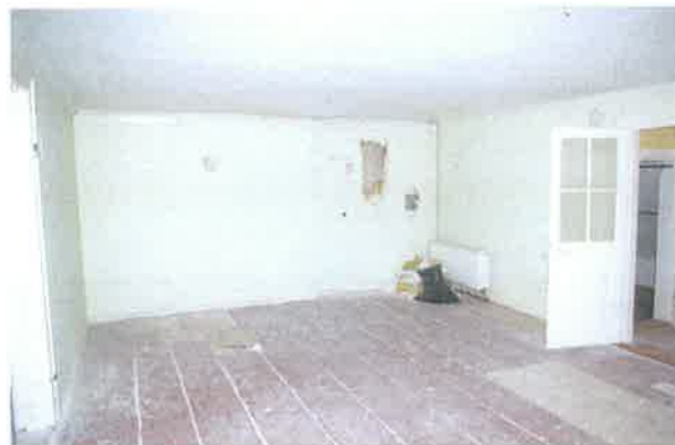
Ściany zachodnia i południowa
