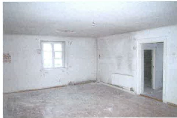
Ściany południowa (z oknem) i zachodnia
