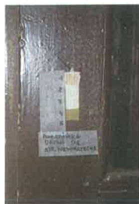
Odkrywka drzwi D1, od wewnątrz
