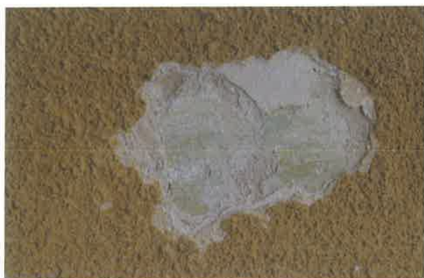
Tynk "baranek" i leżące pod nim warstwy kolorystyczne - różowa i zielona
