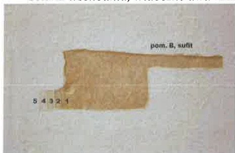
Odkrywka stratygraficzna sufitu.
