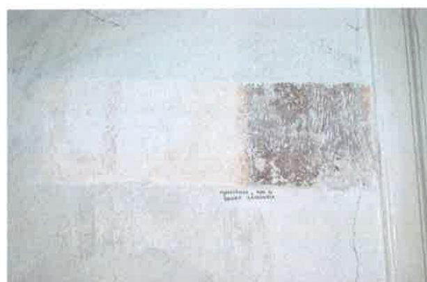
Odkrywka ze ściany zach.
