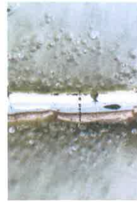
15. Przekrój poprzeczny próbki z drzwi D1
