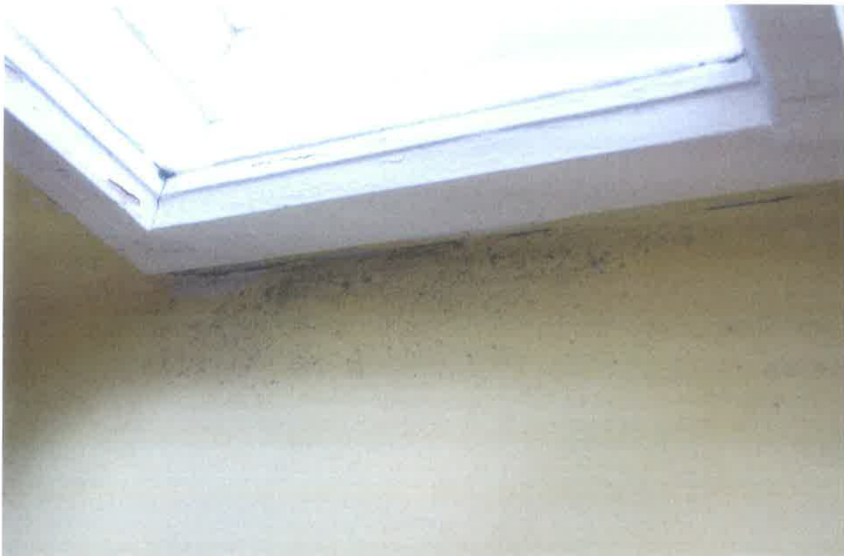
fot. 24. Zagrzybienie na około ościeżnicy.
