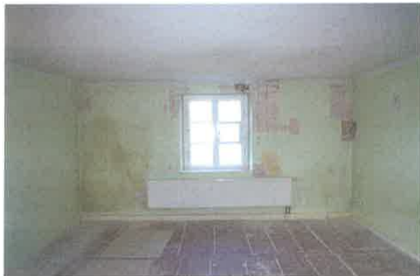
Widok na ścianę północną
