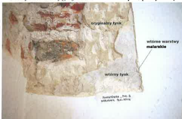
Ściana wschodnia, widoczne dwa rodzaje tynku
