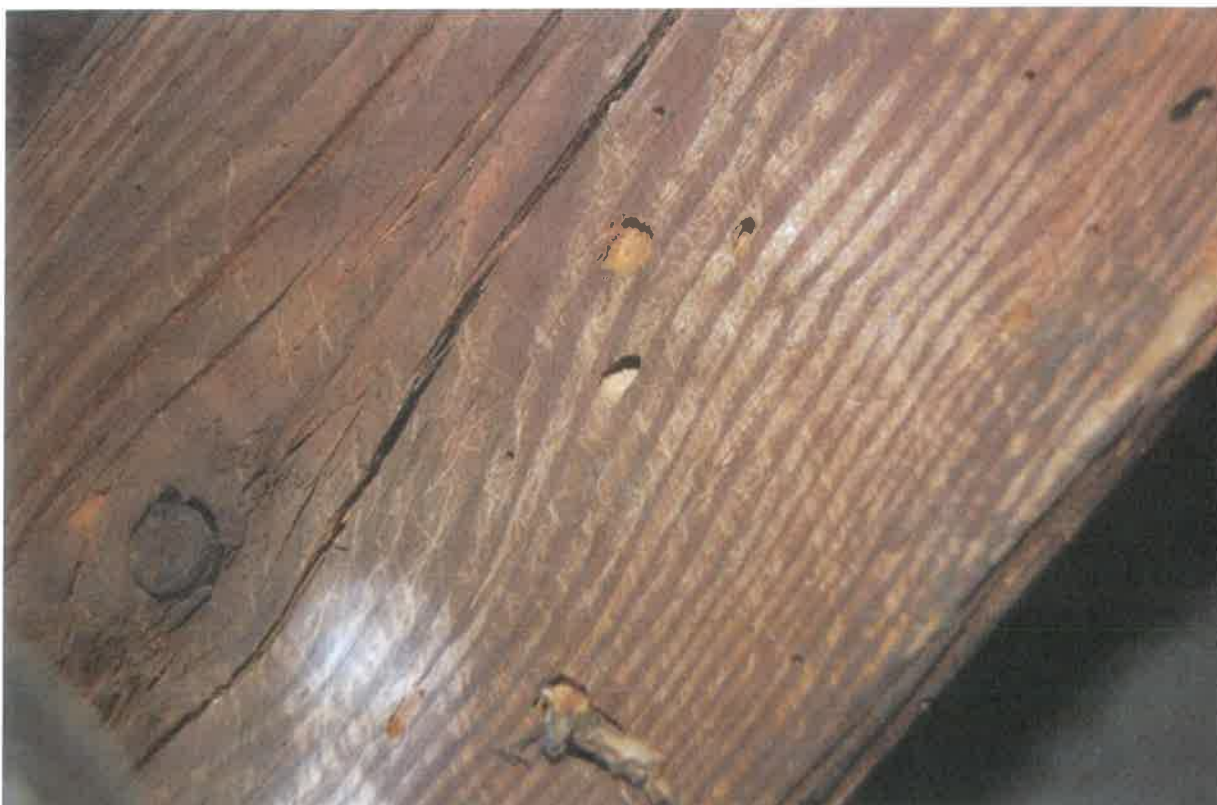
fot. 20. Otwory wylotowe.
