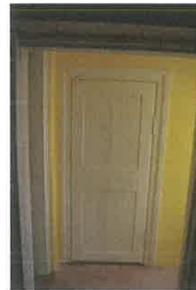
Drzwi do schowka na poddaszu
