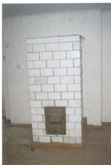
Piec 3 z pomieszczenia D
