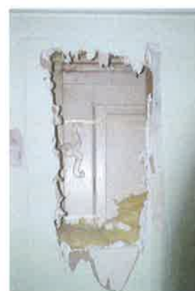
Oryginalne XVIII - wieczne okucie w zabudowanych drzwiach
