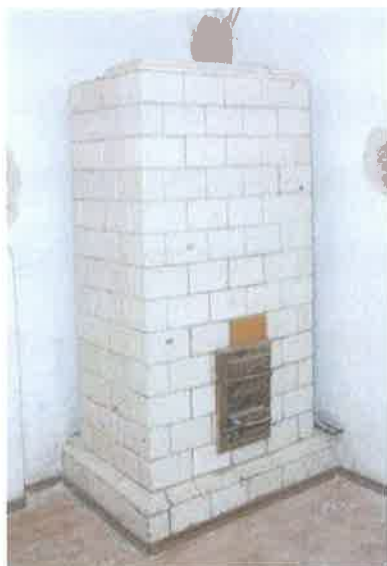
Piec 2 z pomieszczenia B
