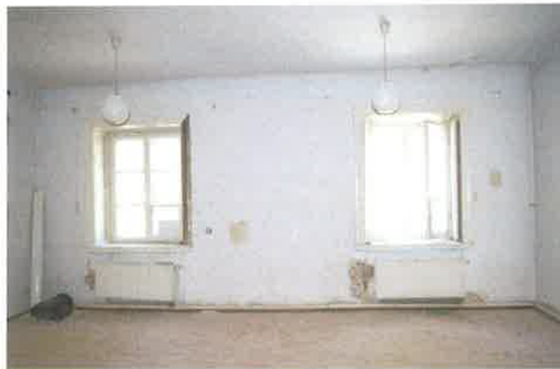
Okna o1 i o2 w pomieszczeniu B
