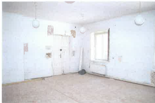
Ściany południowa i zachodnia (z oknem)
