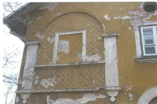
Fragment elewacji północnej
