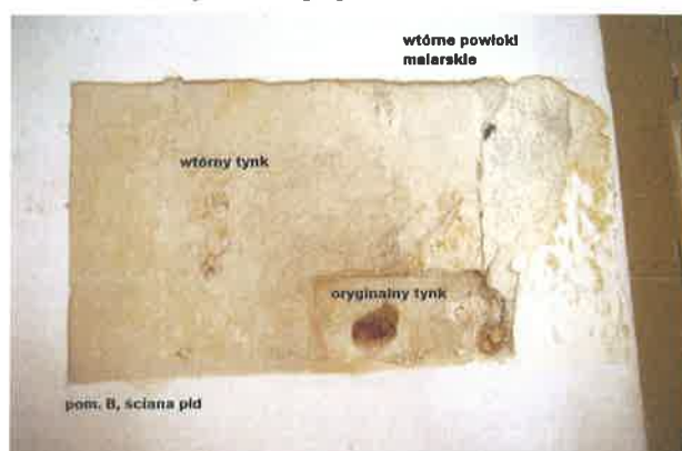
Ściana południowa, widoczne dwa rodzaje tynku
