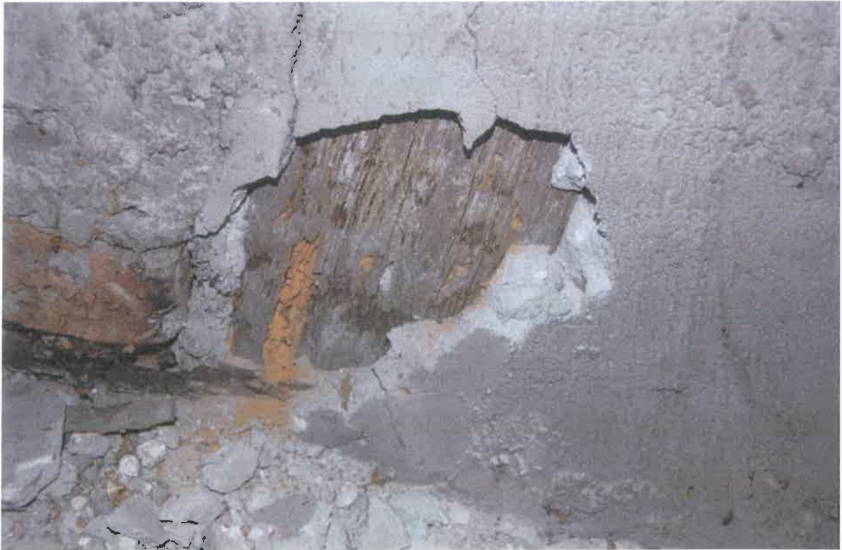
fot. 22. Drewno więźby widoczne pod tynkiem.
