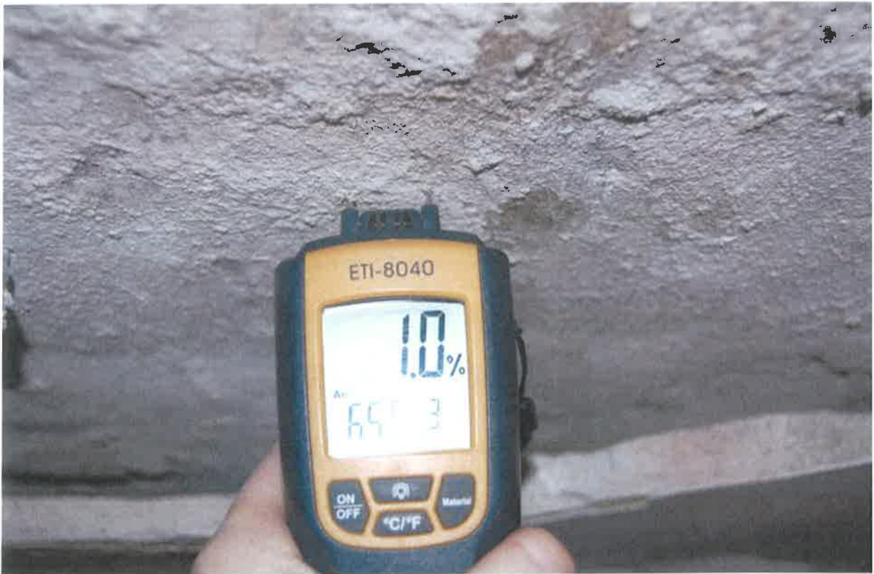
fot. 16. Pomiar wilgotności.
