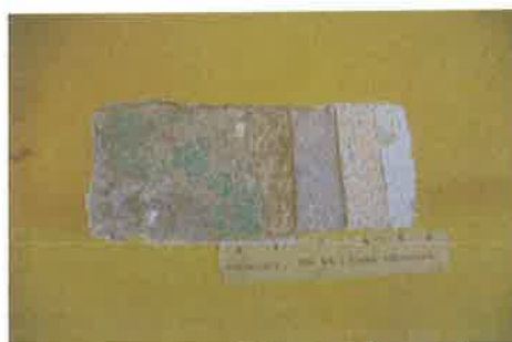
Odkrywka ze ściany południowej pomieszczenia Ea. W najniższej warstwie stwierdzono kolor zielony
