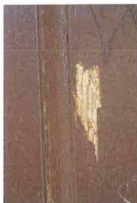
Odkrywka na drzwiach ganku. Na drewnie widoczna biała farba
