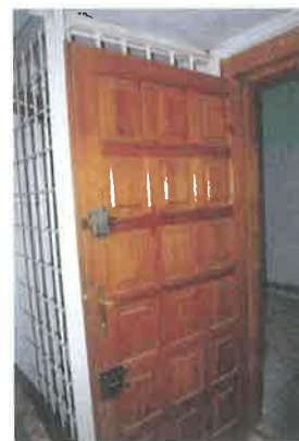
Wtórne drzwi prowadzące do pomieszczenia G
