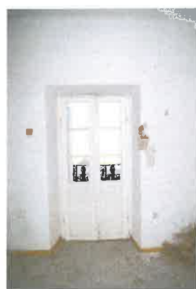
Drzwi wyjściowe na taras wschodni
