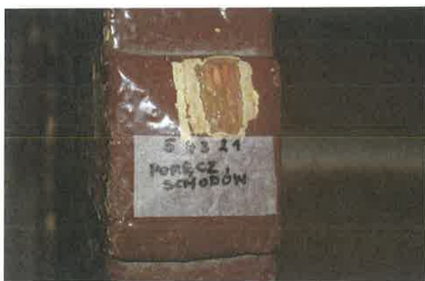
Odkrywka na części drewnianej balustrady
