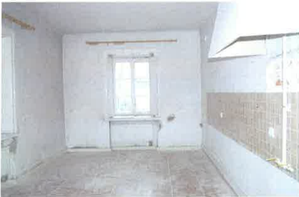
Widok na ścianę południową i zachodnią
