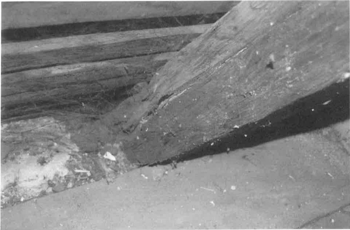
fot. 18. Krokiew ze śladami zerwania spuszcza.
