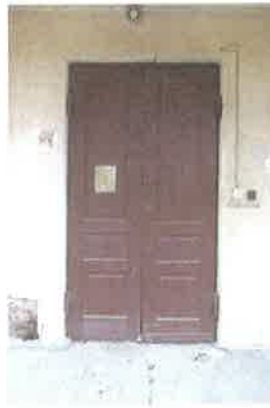
Drzwi D1, strona zewnętrzna
