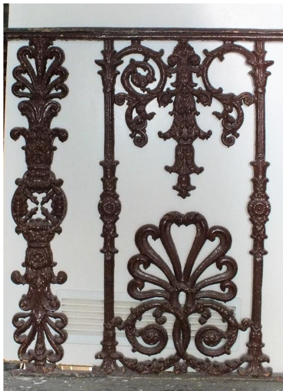
Wzór balustrady złożony z dwóch elementów żeliwnych
