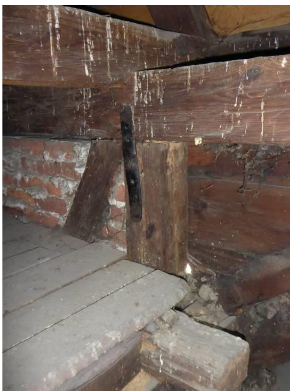
Złącza konstrukcji drewnianej wschodniej części dachu łączone stalowymi elementami
