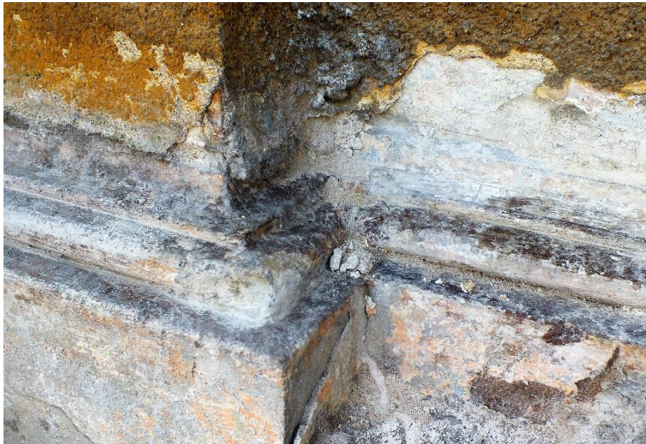
Zachowany profil cokołu przebudowa 1891
