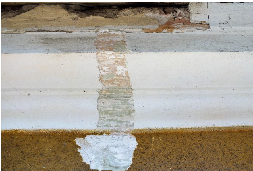
Zachowany profil gzymsu na zachodniej elewacji
