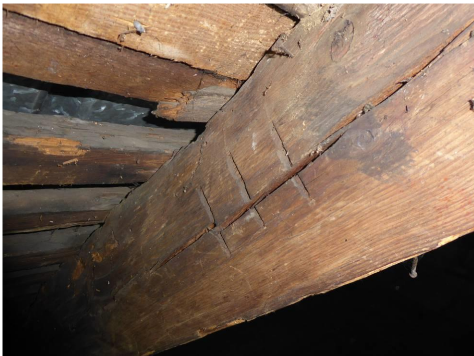
Znaki ciesielskie na krokwi konstrukcji dachu części południowej.
