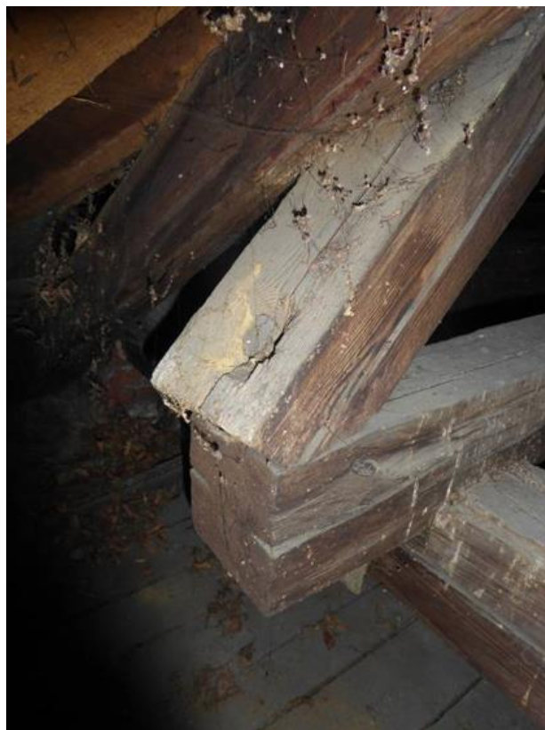
Złącza konstrukcji drewnianej nad wschodnią częścią dachu łączone na stalowe elementy
