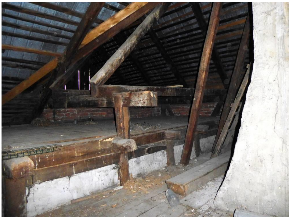
Ściana kolankowa w części północno wschodniej.
