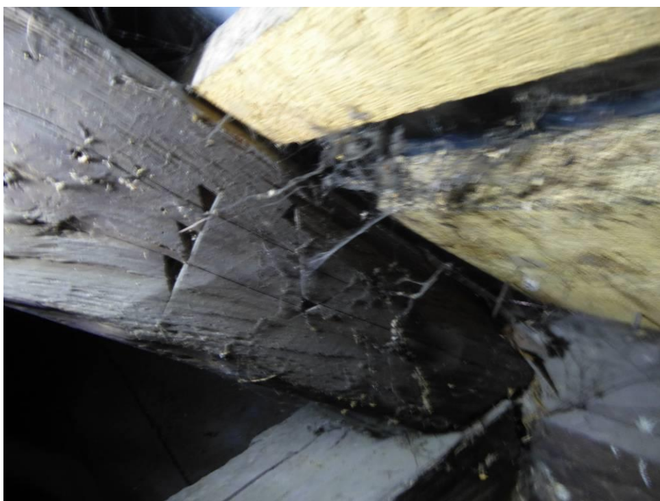
Znaki ciesielskie na krokwi konstrukcji dachu nad ryzalitem wschodnim.
