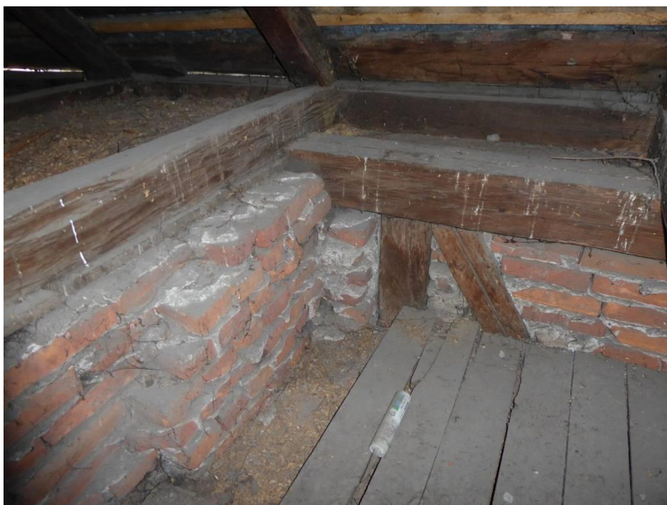
Ściana kolankowa zadaszenia części ryzalitu wschodniego.
