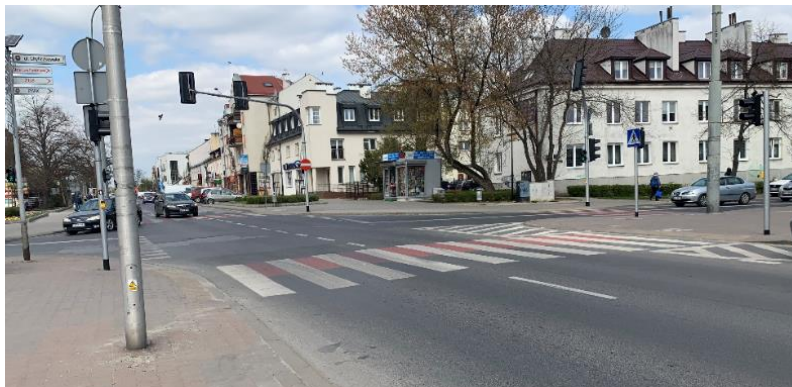
Fot. 2.22. Ulica Puławska – wjazd do ścisłego centrum od strony Warszawy – ulica jednokierunkowa, dwa pasy ruchu – szeroka jezdnia, brak środków organizacji przestrzeni ograniczających prędkość, długie przejście dla pieszych
