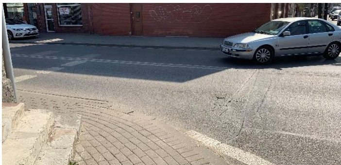
Fot. 2.25. Skrzyżowanie Warszawska/ Chyliczkowska – brak przejścia dla pieszych na zachodnim wlocie.
