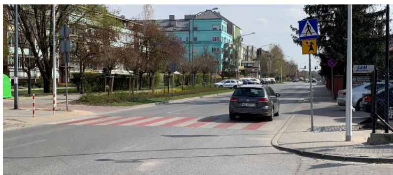
Fot. 2.21. Ul. Powstańców Warszawy, długi odcinek prosty, samochody jeżdżą z dużą prędkością, przejście dla pieszych bez azylu na jezdni o szerokości ok. 8m.
