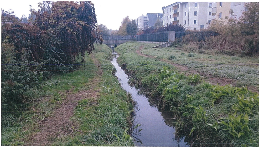
Rys. 1 Widok Kanału Piaseczyńskiego – przepust skrzynkowy od ul. Nadarzyńskiej
