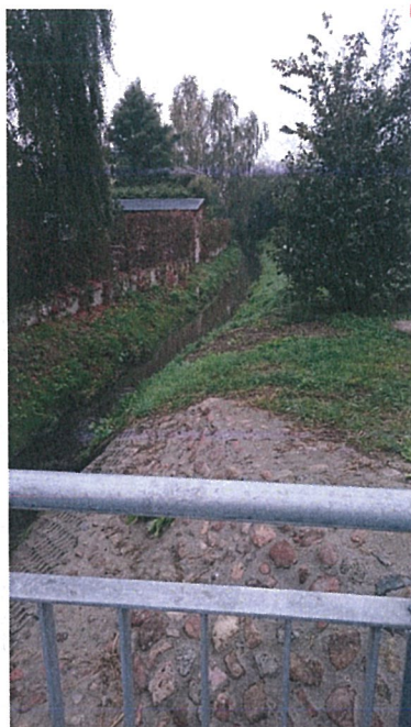
Rys. 3 Widok Kanału Piaseczyńskiego z przebudowanego mostu w ciągu ul. Kniaziewiczza
