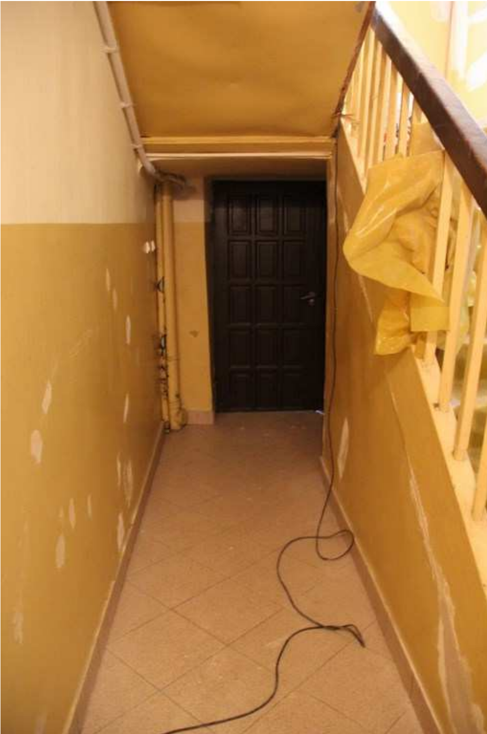
Komunikacja, klatka schodowa
