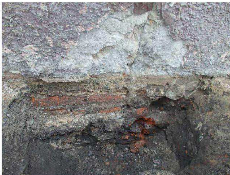
Fot. 4. Widok odkrywki fundamentów od strony ściany szczytowej
