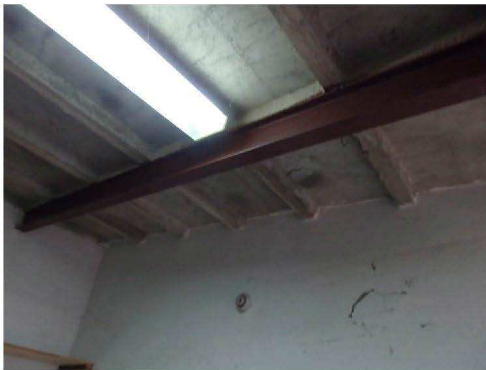
Fot. 6. Widok konstrukcji dachu z elementów prefabrykowanych
