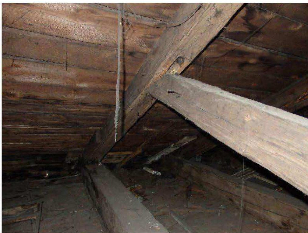
Fot. 5. Widok drewnianych elementów więźby dachowej
