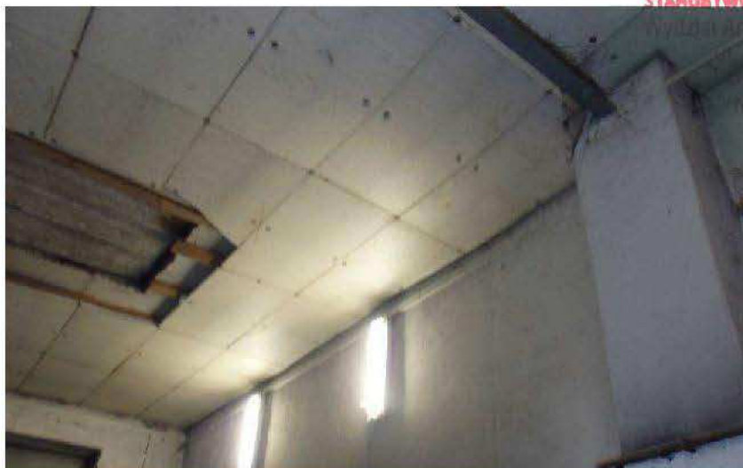
Fot. 21. Widok docieplonego sufitu w pomieszczeniu warsztatowym (pomieszczenie nr 6)
