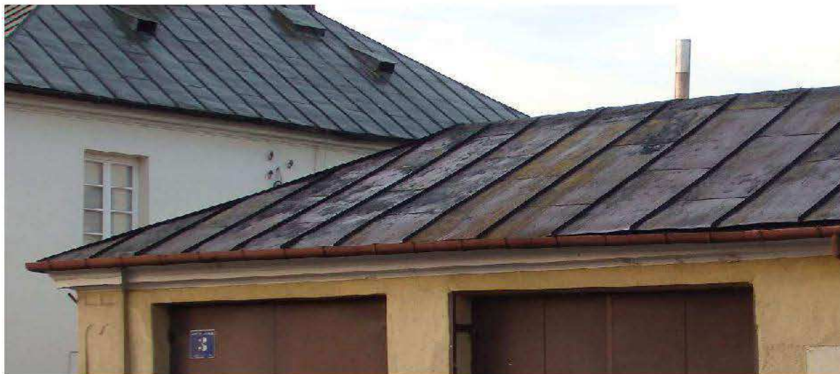
Fot. 7. Widok pokrycia dachu z blachy
