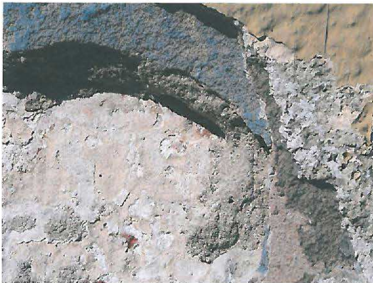
Kolejne nawarstwienia tynków i malowania elewacji frontowej
