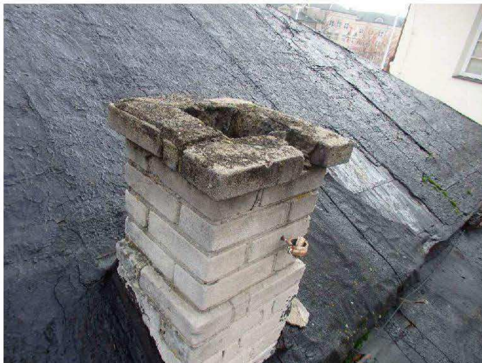
Fot. 9. Widok komina nieotynkowanego w części pierwotnej budynku
