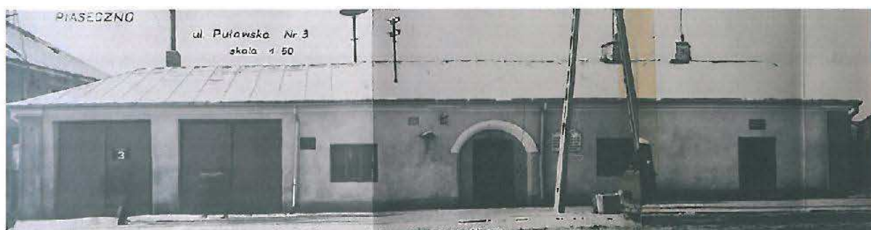
Lata 1960. Powiększone wjazdy garażowe w miejscu bram garażowych nr 1, 2. Brama garażowa nr 3 zamurowana z wykonaniem okna, zlikwidowane arkady poza bramą garażową nr 4, zmienione drzwi w bramie garażowej nr 4, zlikwidowana dobudowa sieni. (archiwum WKZ)
