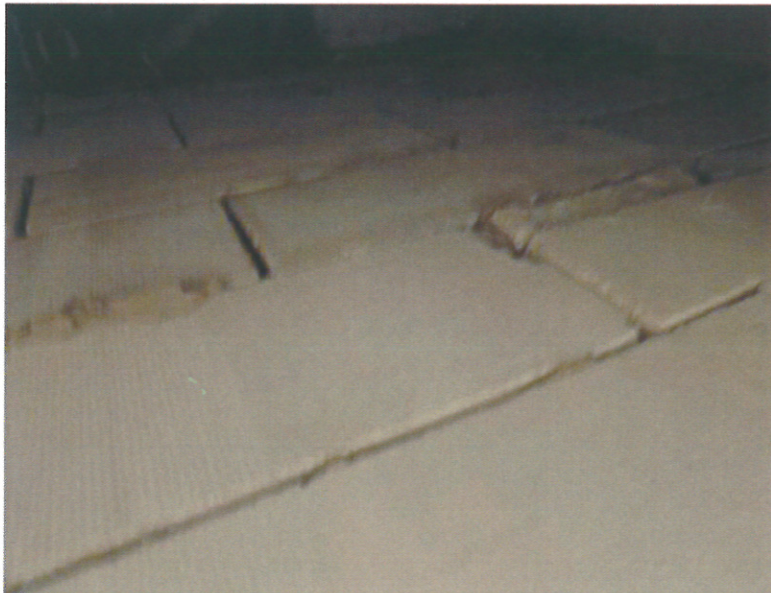
Zdjęcie [O-02] Stan techniczny budynku sądu rejonowego w Piasecznie przy ul. Kościuszki 14, w dniu 2 czerwca 2017 r. Widok ściany od strony szachtu instalacyjnego wymurowana z minimalną ilością kleju na spoinie poziomej, spoin pionowych brak, zbyt duże szczeliny. Nieprecyzyjne ułożenie elementów murowych
