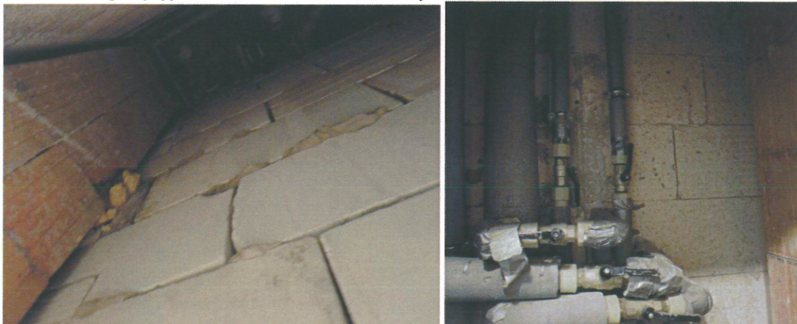
Zdjęcie [O-02] Stan techniczny budynku sądu rejonowego w Piasecznie przy ul. Kościuszki 14, w dniu 2 czerwca 2017 r. Widok ściany od strony szachtu instalacyjnego wymurowana z minimalną ilością kleju na spoinie poziomej, spoin pionowych brak, zbyt duże szczeliny. Nieprecyzyjne ułożenie elementów murowych
