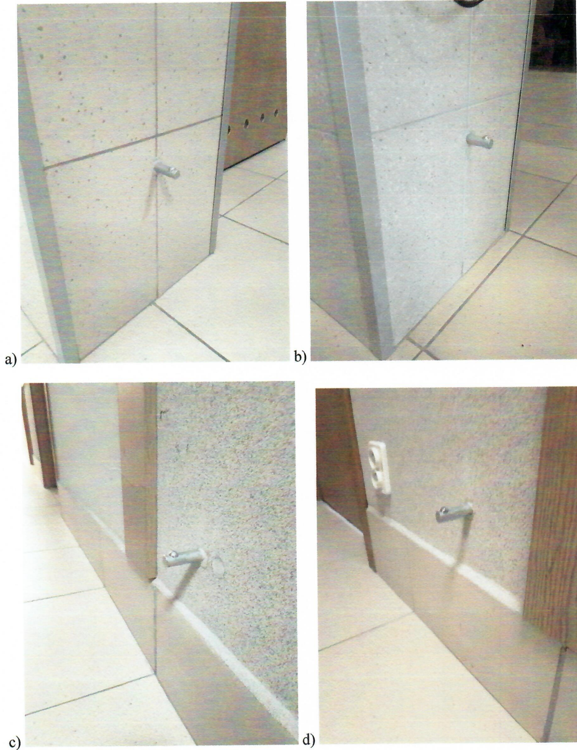
Rys. 3. Stabilizacja wybranych reperów kontrolowanych: a) reper 10, b) reper 13, c) reper 19, d) reper 20.
