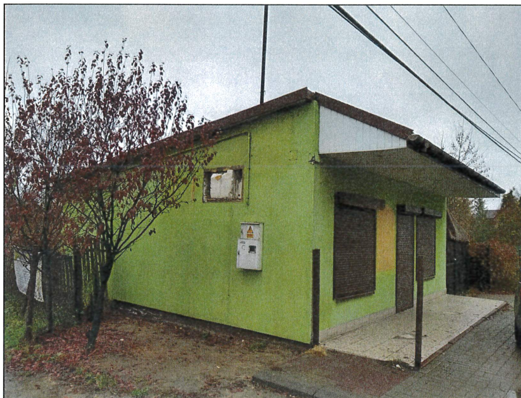
Fot. nr 1 Elewacja Południowo Zachodnia
