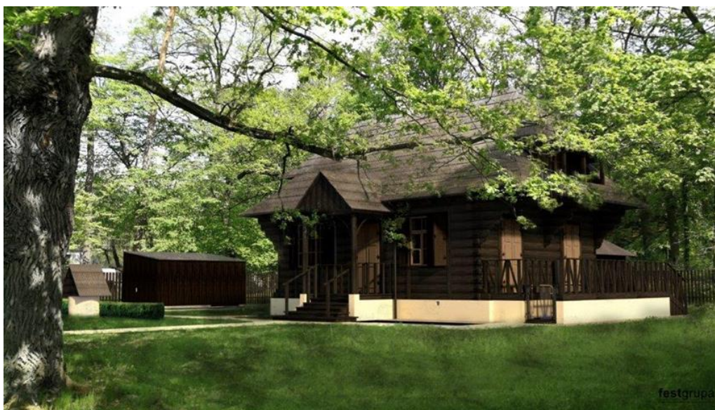
Wizualizacja obiektu po zakończeniu prac.
