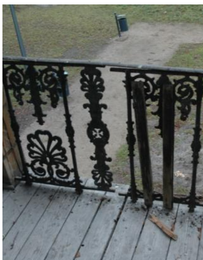
Ilustracja 15. Balustrada ganku na I piętrze. Widoczne odkształcenia i braki poszczególnych elementów balustrady, 12.2019, źródło: własne
