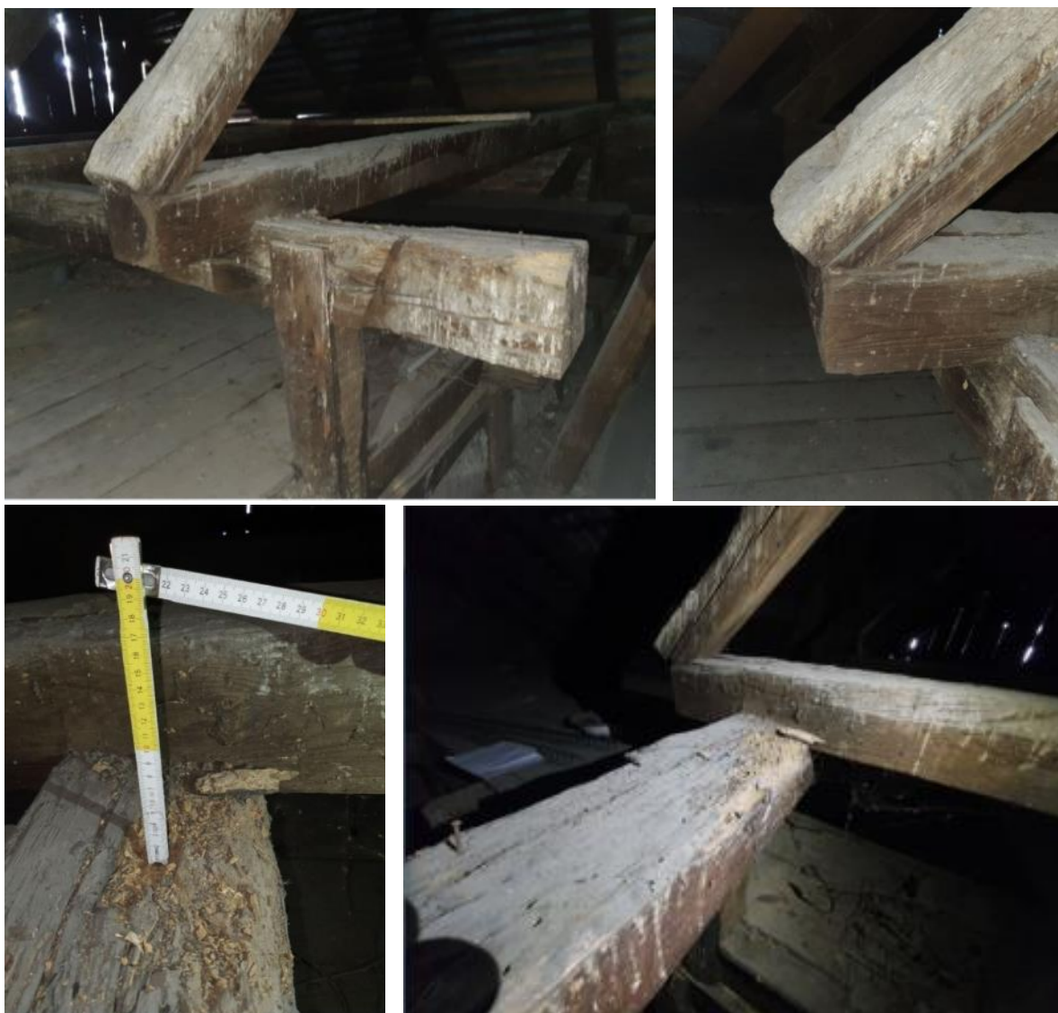
Ilustracja 57. W części nad pomieszczeniem G konstrukcja ganku wschodniego wsparta jest na drewnianych słupach wyciągniętych ze ściany szachulcowej, widoczne ubytki drewna i korozja biologiczna, źródło: własne
