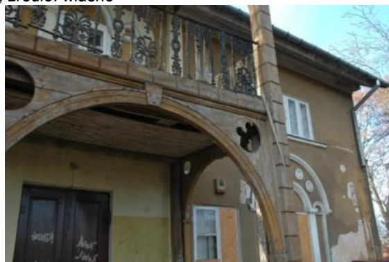
Ilustracja 16. Po lewej: Pięciopanelowe okno na elewacji wschodniej i wtórna kratka wentylacyjna na elewacji, po prawej: uszkodzenia ganku wschodniego, 12.2019, źródło: własne
