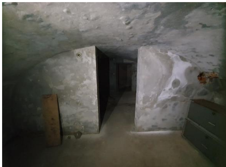
Fotografia 6 i 7 - Schody do piwnicy z ostatnim stopniem zabiegowym(po lewej), ściana z pustym otworem drzwiowym dzielącym pomieszczenie P1 na dwie części -1.2 i -1.3 (po prawej)
