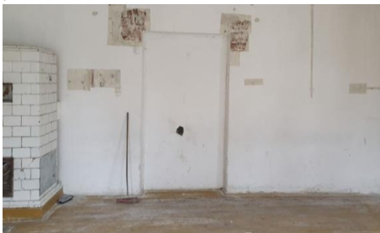
Ilustracja 63. Wtórnie przesłonięte drzwi łączące amfiladowo sale A i C, źródło: własne
