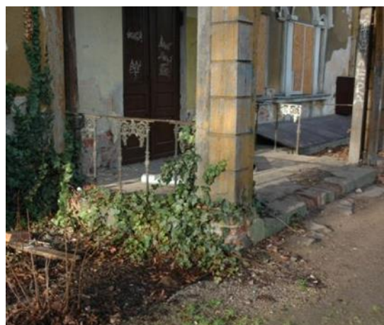
Ilustracja 14. Po lewej: nisza zwieńczona arkadą – obecnie pusta, dawniej był na niej ustawiony posąg fortuny (obecnie uszkodzony i przechowywany w magazynie), po prawej: dolna część ganku wschodniego – znaczne uszkodzenia podbudowy, brak zachowanej posadzki, silne uszkodzenia balustrad, 12.2019, źródło: własne
