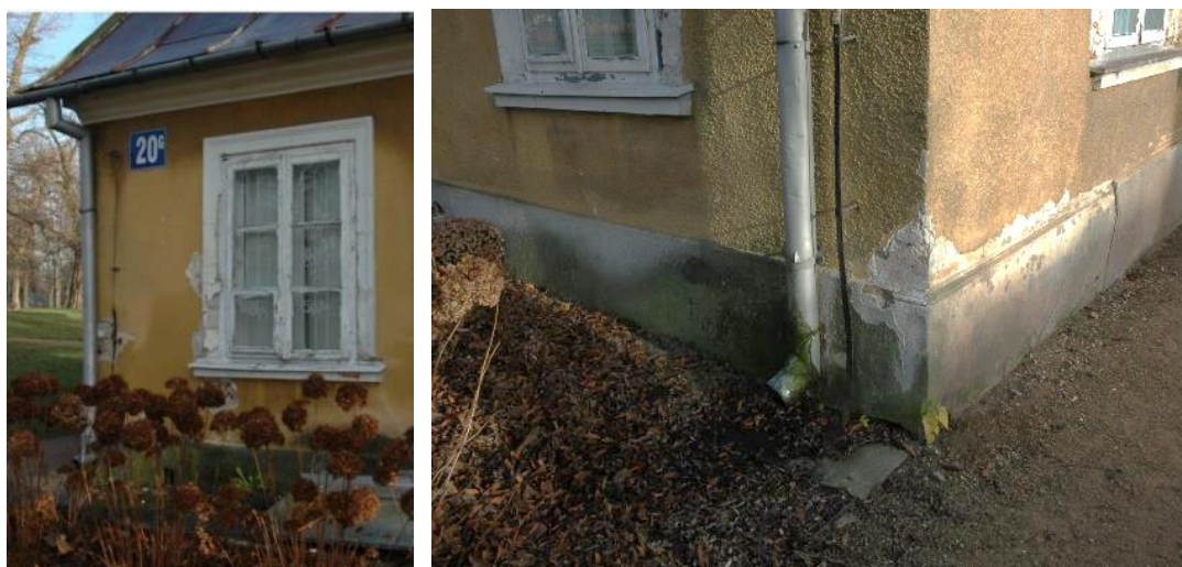
Ilustracja 11. Po lewej: znaczne zawilgocenie i korozja mikrobiologiczna budynku w strefie cokołu, uszkodzenia tynku oraz opasek okiennych i stolarki. Profilowany cokół tynku romańskiego wtórnie pokryty tynkiem cementowym, 12.2019, źródło: własne
