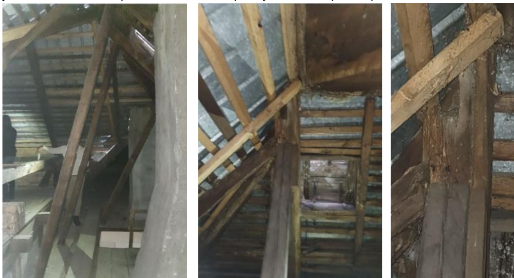
Ilustracja 54. Po lewej: ukośne wzmocnienia więzby przy połączeniu wyższej części północnej i niższej południowej, po środku i po prawej: podparcie wężła ukośnym słupem i widoczna destrukcja połączeń, źródło: własne
