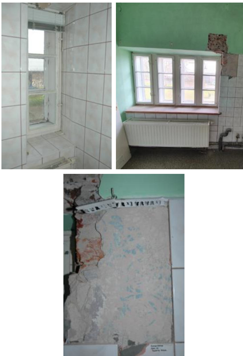
Ilustracja 48. Pomieszczenie G - pięciosiowe okno przedzielone wtórną ścianą i odkrywka polichromii na ścianie wschodniej, 12.2019, źródło: własne
