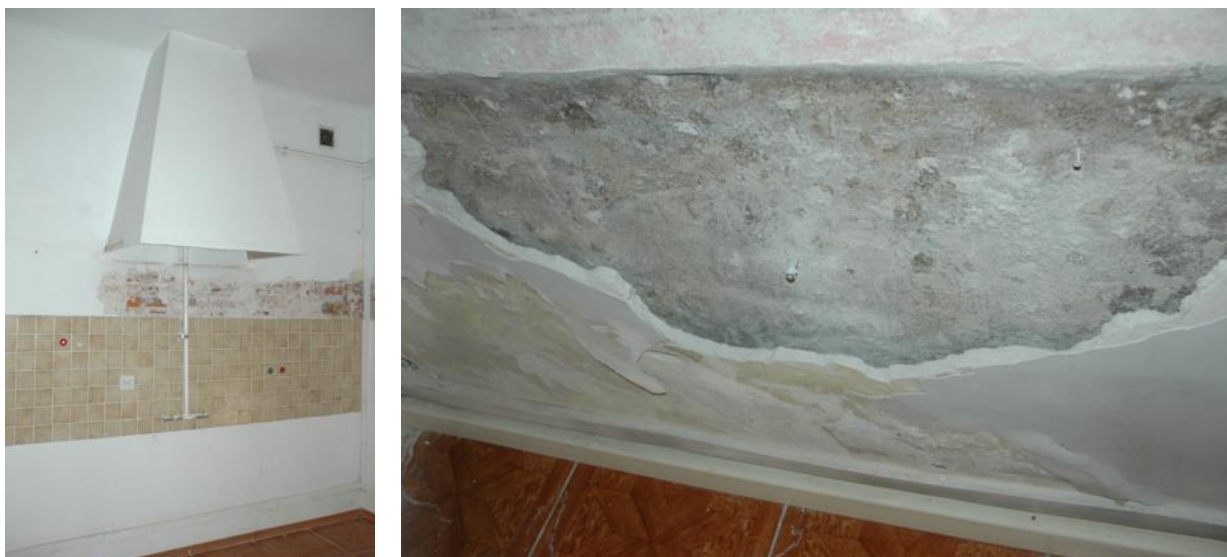
Ilustracja 34. Pomieszczenie C, po lewej: ściana zachodnia -pozostałości współczesnej zabudowy kuchennej i odkrywka ukazująca przemurowanie ściany, po prawej: podcięcie tynku do wysokości 60-70 cm na ścianie wschodniej, mające na celu przeciwdziałanie zawilgoceniu 12.2019, źródło: własne
