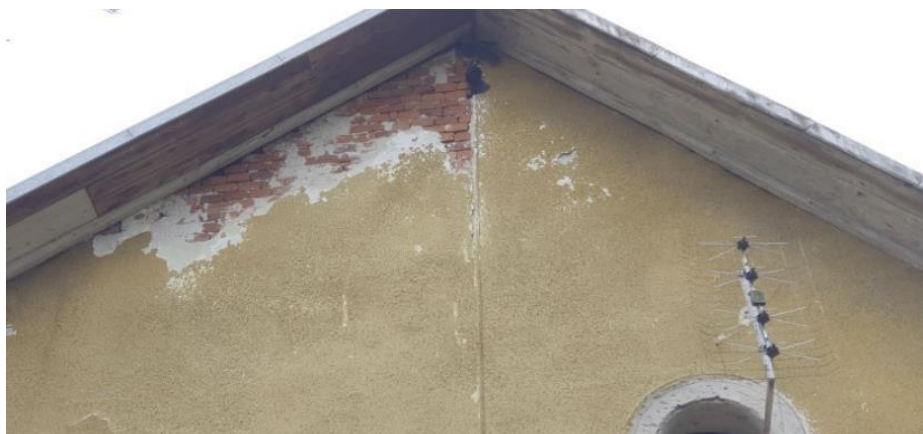
Ilustracja 89. Znacznych rozmiarów gniazdo kawek przy północnej elewacji obciążające strop, ptaki dostają się na przestrzeń poddasza przez okulus i otwór u szczytu elewacji, źródło: własne
