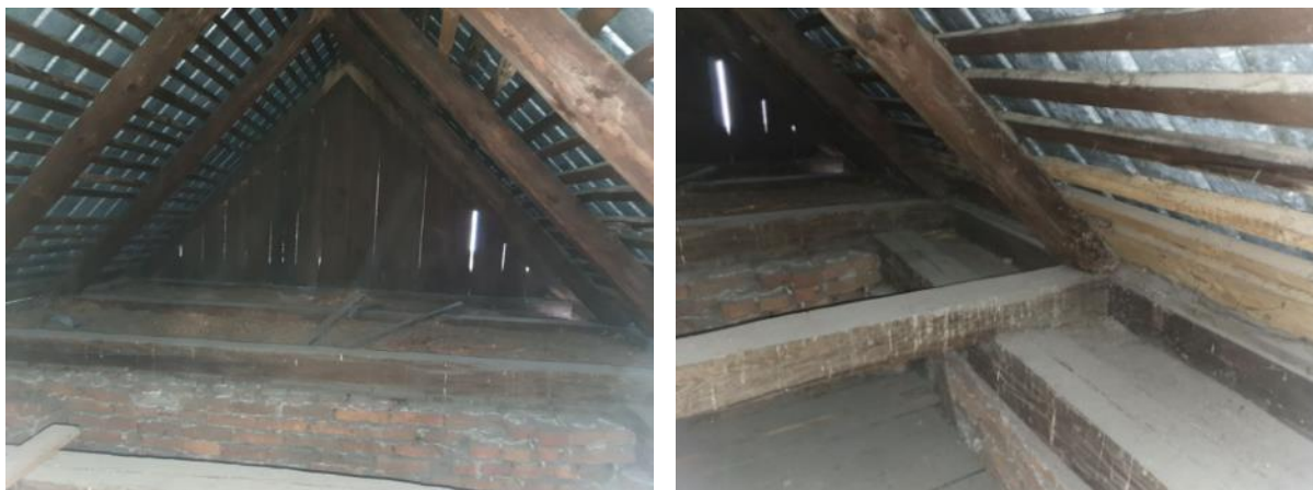
Ilustracja 56. Widok na konstrukcję dachu ganku wschodniego (na pierwszym planie ceglany murek - zewnętrzna wschodnia ściana Poniatówki. Za ścianą konstrukcja dachu opiera się na słupach ganku), po prawej: oparcie więzara na murłacie, źródło: własne
