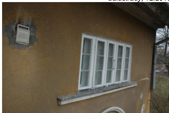
Ilustracja 16. Po lewej: Pięciopanelowe okno na elewacji wschodniej i wtórna kratka wentylacyjna na elewacji, po prawej: uszkodzenia ganku wschodniego, 12.2019, źródło: własne
