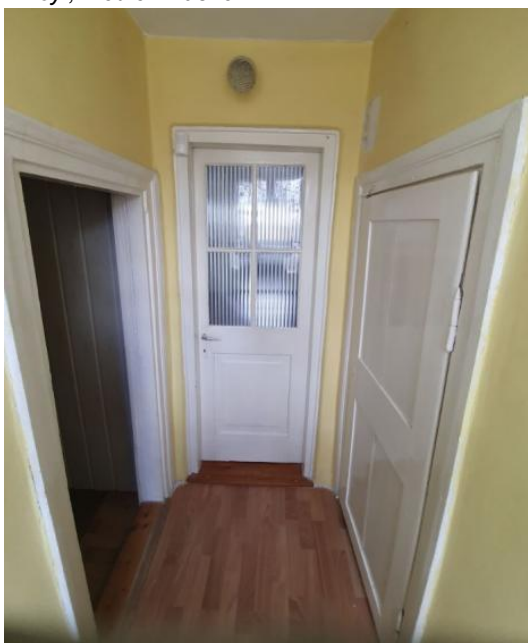
Ilustracja 68. Po lewej: drzwi z D do DA - brak skrzydła drzwiowego, po prawej: drzwi z E do Ea - XIX wieczne ze wtórną szybą, drzwi z Ea do stryszków - nie zachowane jedno skrzydło drzwiowe, źródło: własne
