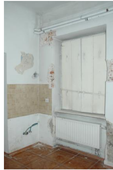
Ilustracja 35. Pomieszczenie K, po lewej: ściana zachodnia: pozostałości współczesnej zabudowy kuchennej i odkrywka ukazująca przemurowanie ściany, po prawej podcięcie tynku do wysokości 60-70 cm na ścianie wschodniej, mające na celu przeciwdziałanie zawilgoceniu 12.2019, źródło: własne
