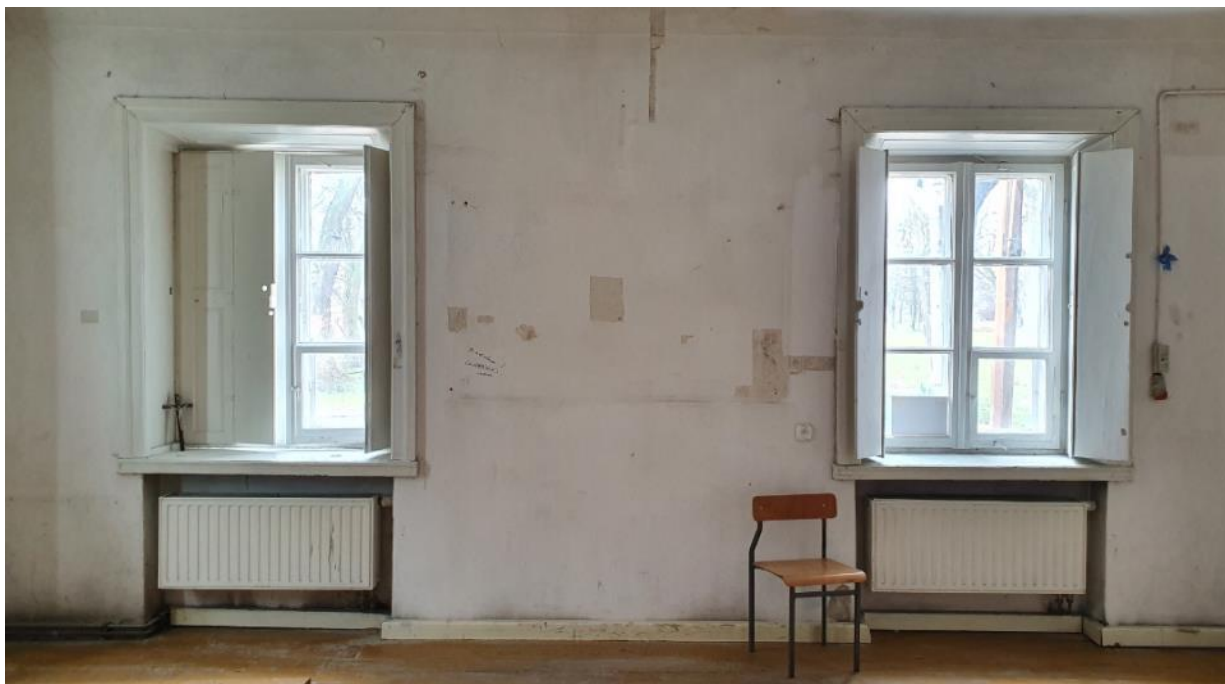
Ilustracja 71. Na parterze - stolarka okienna XIX wieczna, skrzynkowa, okna sześciokwaterowe ze składanymi okiennicami (za wyjątkiem okna w K, gdzie inny system okiennic), źródło: własne
