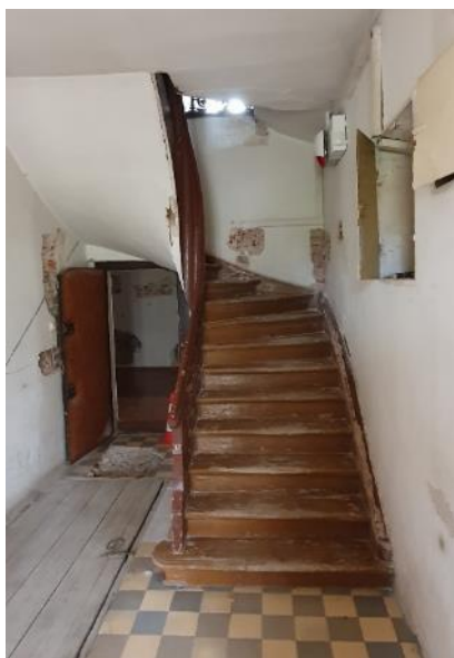
Fotografia 8 i 9 - Zabiegowe schody na piętro i widok na zlokalizowane obok nich schody do piwnicy zamknięte klapą (po lewej), widok ze schodów na pierwsze piętro w kierunku
