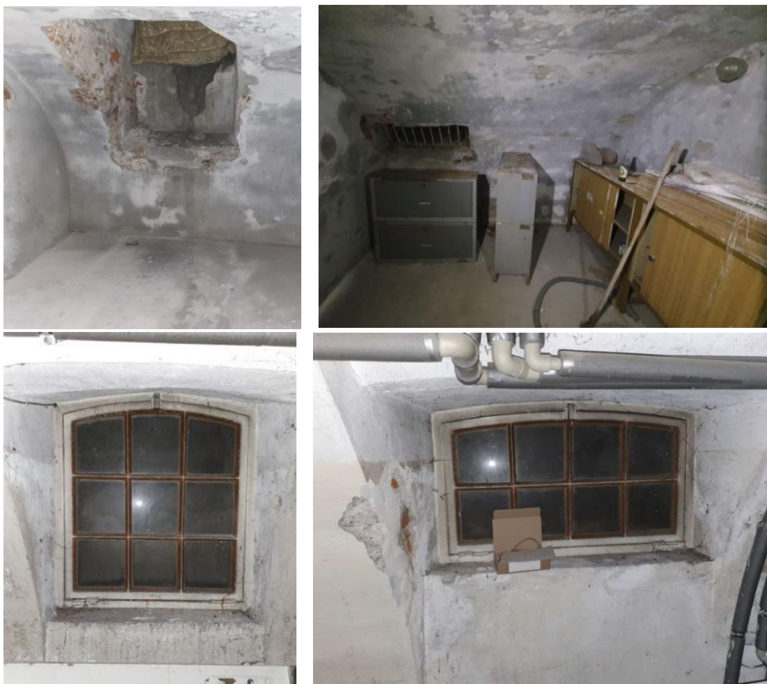
Ilustracja 69. W piwnicy - w pomieszczeniu P1 (u góry) brak stolarki okiennej. Okna wyposażone w kraty. W pomieszczeniu P2 (na dole)- dwa stalowe okna XIX wieczne z nadprożem odcinkowym, źródło: własne
