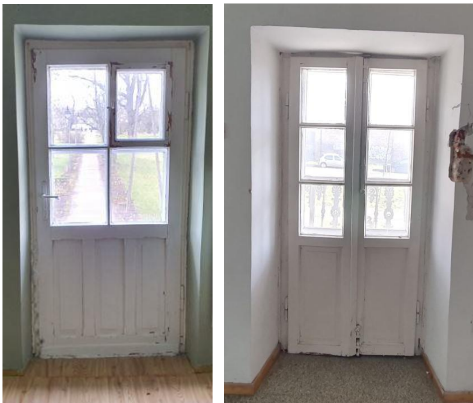
Ilustracja 73. Drzwi podwójne przeszklone na ganki. Po lewej - drzwi na dach ganku zachodniego z uchylną kwaterą, po prawej - drzwi na ganek zachodni, źródło: własne
