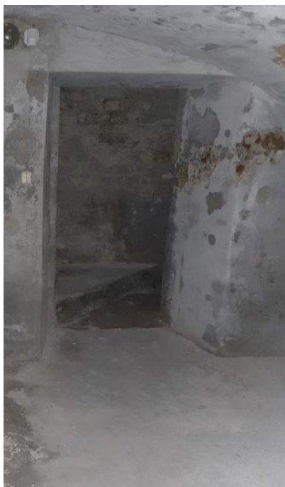
Ilustracja 60. W piwnicy - nie zachowały się drzwi historyczne. Po lewej drzwi z klatki schodowej do P1 - nie zachowane, po prawej - drzwi stalowe pomiędzy pomieszczeniami P1 i P2, źródło: własne
