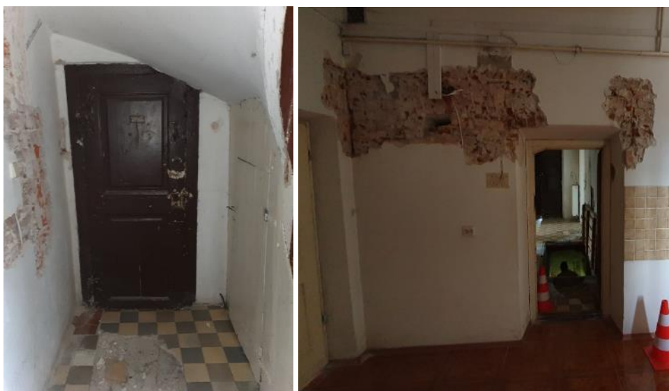
Fotografia 10 i 11 - Zaniżenie wysokości przejścia w holu głównym pod biegiem schodowym na pierwsze piętro (po lewej) i zarys szerokiego odcinkowego nadproża widoczny od strony pomieszczenia K – projektowanego holu przed toaletą (po prawej).
