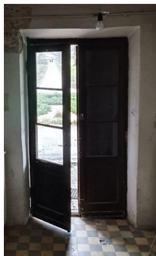
Ilustracja 61. Na parterze XIX-wieczne podwójne dwuskrzydłowe drzwi (wewnętrzne, przeszklone - otwierają się do środka budynku, zewnętrzne, pełne - otwierają się na zewnątrz), po lewej : drzwi od strony wschodniej, po prawej: drzwi od strony zachodniej budynku, źródło: własne
