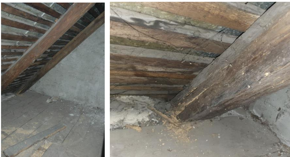
Ilustracja 52. Strych przy pomieszczeniu D, widoczne poważne osłabienie krokwi, aktywne ślady żerowania spuszczela oparcia, źródło: własne
