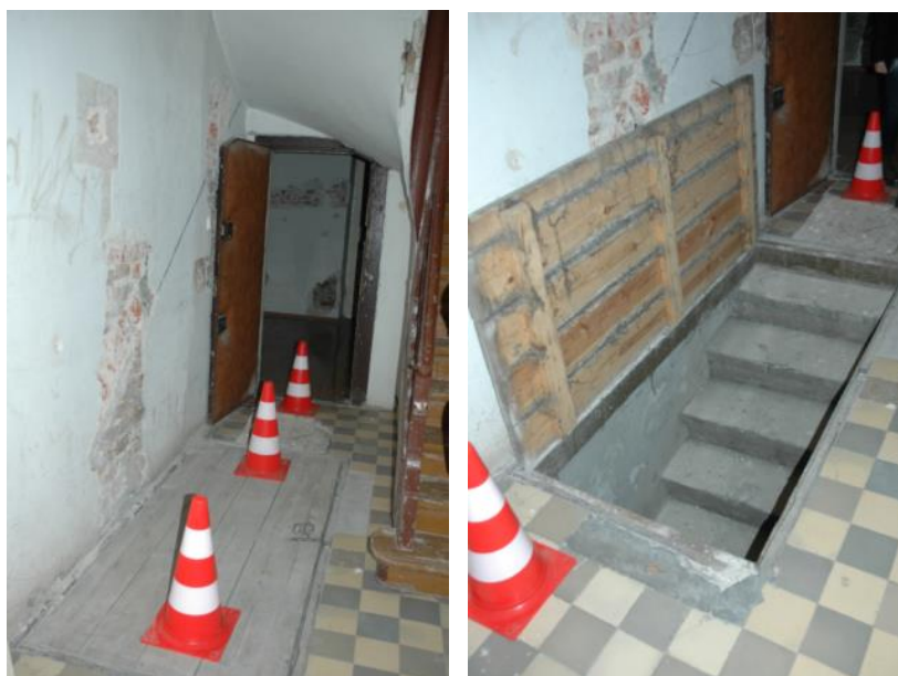
Ilustracja 37. Pomieszczenie S, po lewej: na ścianie widoczny ślad sklepienia nad schodami piwnicy/ dawnych schodów na piętro , po prawej schody do piwnicy, 12.2019, źródło: własne
