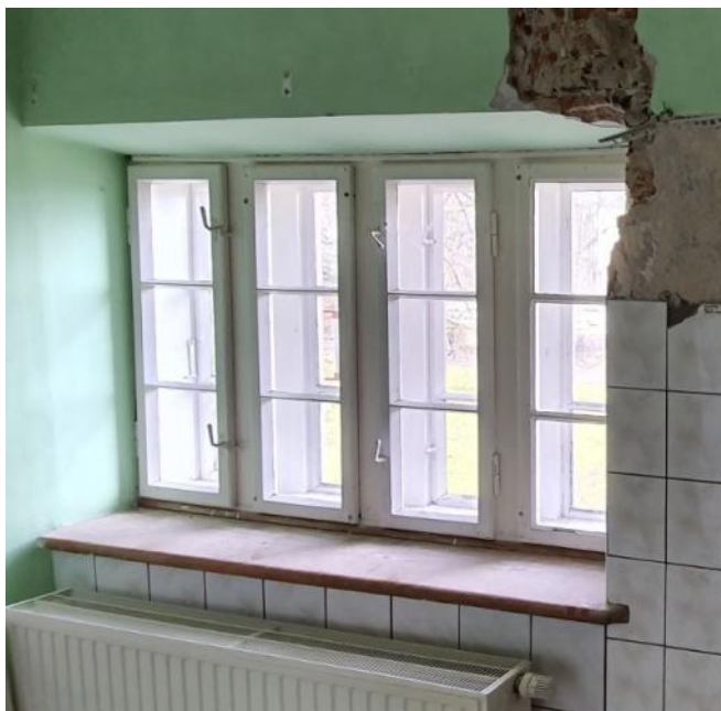
Ilustracja 72. Na I piętrze - stolarka okienna XIX wieczna, skrzynkowa, wszystkie okna sześciokwaterowe (po lewej) za wyjątkiem pięcioosiowego okna w pomieszczeniu G (po prawej), źródło: własne
