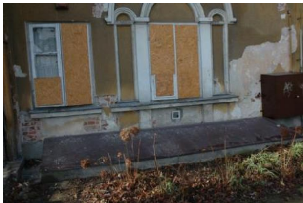
Ilustracja 13. Po lewej: zawilgocenie i korozja mikrobiologiczna w strefie cokołu, po prawej: uszkodzenia tynku, detali, okien. W dolnej części elewacji zabudowa wtórnego silosu na węgiel, 12.2019, źródło: własne
