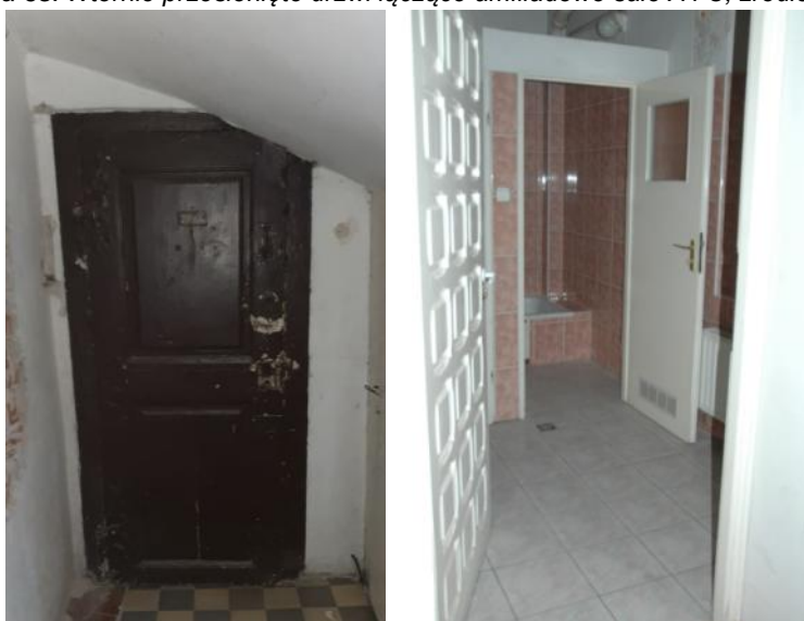
Ilustracja 64. Po lewej: drzwi zlokalizowane pod schodami na piętro, prowadzące z holu S do pomieszczenia K VIII-wieczne, ze ściętym przez spód schodów narożem, od strony wschodniej wtórnie obite sztuczną skórą. Drzwi te historycznie były zlokalizowane w innej części budynku i zostały przeniesione pod schody, po prawej: drzwi z K do T i wewnątrz kabin ustępowych - współczesne, źródło: własne
