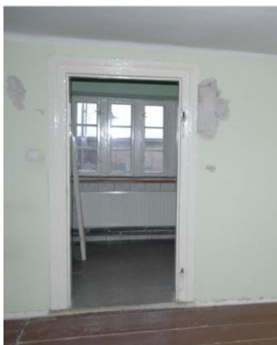
Ilustracja 67. Drzwi pomiędzy G i E - XVII-wieczna rama osadzona w pogrubiłej dachówkami ścianie (w czasie przebudowy w 1891 roku). XVIII-wieczne skrzydło drzwiowe zdemontowane i przechowywane obecnie w piwnicy., źródło: własne
