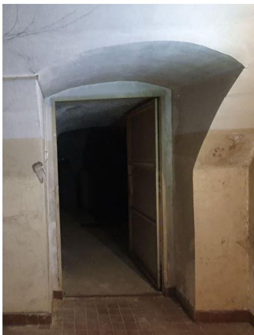
Ilustracja 60. W piwnicy - nie zachowały się drzwi historyczne. Po lewej drzwi z klatki schodowej do P1 - nie zachowane, po prawej - drzwi stalowe pomiędzy pomieszczeniami P1 i P2, źródło: własne
