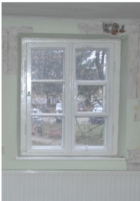
Ilustracja 72. Na I piętrze - stolarka okienna XIX wieczna, skrzynkowa, wszystkie okna sześciokwaterowe (po lewej) za wyjątkiem pięcioosiowego okna w pomieszczeniu G (po prawej), źródło: własne
