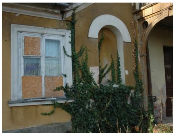
Ilustracja 14. Po lewej: nisza zwieńczona arkadą – obecnie pusta, dawniej był na niej ustawiony posąg fortuny (obecnie uszkodzony i przechowywany w magazynie), po prawej: dolna część ganku wschodniego – znaczne uszkodzenia podbudowy, brak zachowanej posadzki, silne uszkodzenia balustrad, 12.2019, źródło: własne
