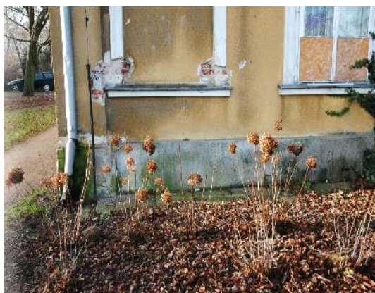
Ilustracja 13. Po lewej: zawilgocenie i korozja mikrobiologiczna w strefie cokołu, po prawej: uszkodzenia tynku, detali, okien. W dolnej części elewacji zabudowa wtórnego silosu na węgiel, 12.2019, źródło: własne
