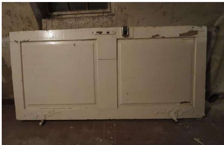
Ilustracja 67. Drzwi pomiędzy G i E - XVII-wieczna rama osadzona w pogrubiłej dachówkami ścianie (w czasie przebudowy w 1891 roku). XVIII-wieczne skrzydło drzwiowe zdemontowane i przechowywane obecnie w piwnicy., źródło: własne
