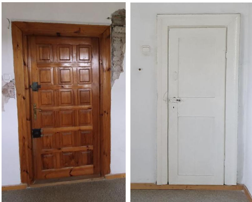
Ilustracja 66. Po lewej: drzwi z klatki schodowej do pomieszczenia G - wtórne, po prawej: drzwi z G na stryszek wschodni - zachowane XIX-wieczne, źródło: własne
