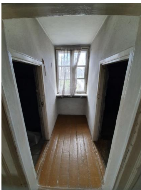
Ilustracja 68. Po lewej: drzwi z D do DA - brak skrzydła drzwiowego, po prawej: drzwi z E do Ea - XIX wieczne ze wtórną szybą, drzwi z Ea do stryszków - nie zachowane jedno skrzydło drzwiowe, źródło: własne
