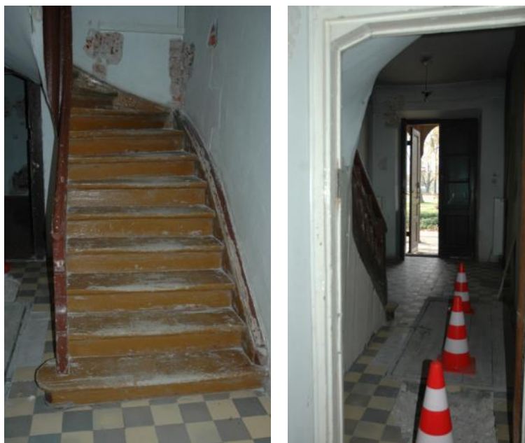
Ilustracja 36. Pomieszczenie S, po lewej: drewniane schody na piętro z czasów przebudowy w 1891r, po prawej: widok z pomieszczenia K w kierunku holu, widoczne ubytki i uszkodzenia płytek oraz ścięcie narożnika drzwiowego, 2019, źródło: własne
