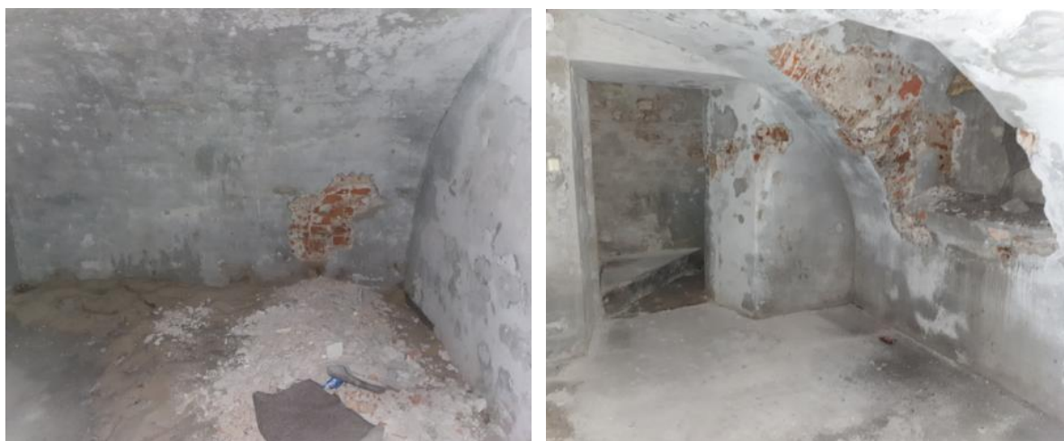
Ilustracja 22. Piwnica P1, po lewej: widok odkrywki ukazującej zamurowane niskie przejście do piwnicy P2, po prawej : widok na w kierunku klatki schodowej i poszerzonego otworu okiennego, 12.2019, źródło: własne
