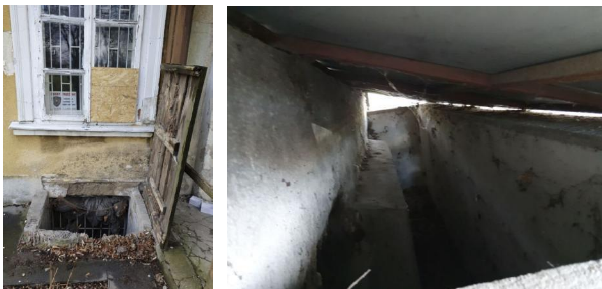
Ilustracja 70. Po lewej - studnie okienne okien piwnicznych P1 przykryte blachą na konstrukcji drewnianej, po prawej - silos betonowy spełniający funkcję studni okien P2 przestłonięty blachą na stalowej ramie, źródło: własne
