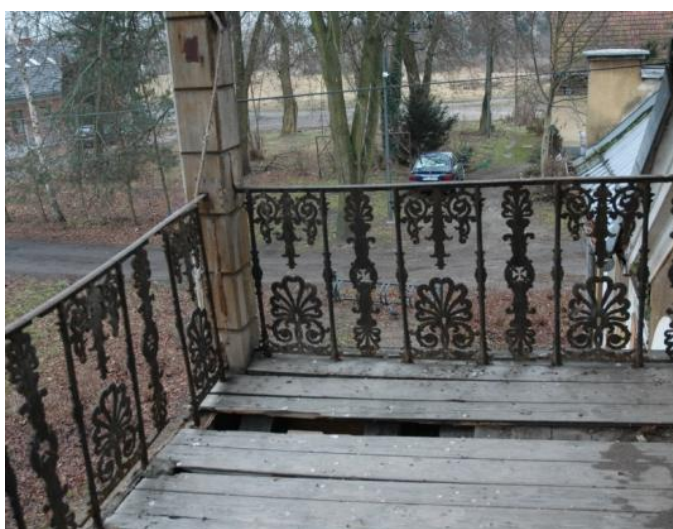
Ilustracja 15. Balustrada ganku na I piętrze. Widoczne odkształcenia i braki poszczególnych elementów balustrady, 12.2019, źródło: własne
