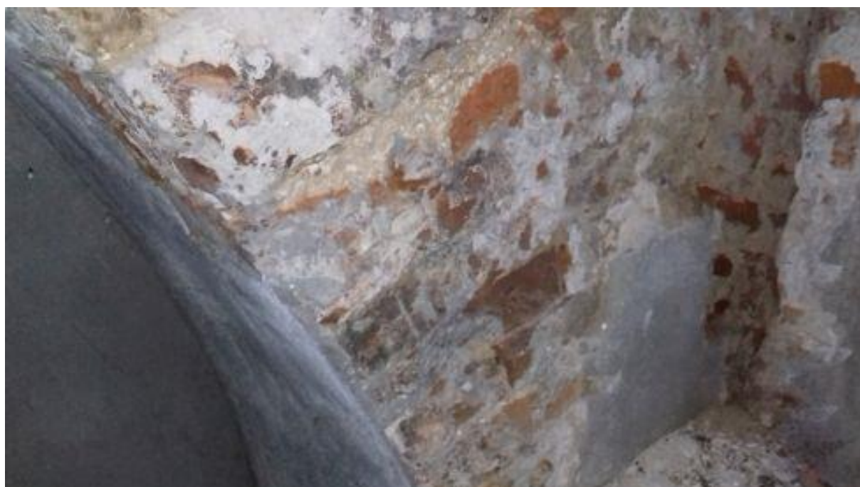
Degradacje wypraw tynkarskich na ścianie wewnętrznej w piwnicy.
