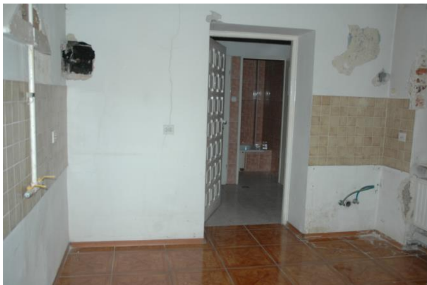
Ilustracja 35. Pomieszczenie K, po lewej: ściana zachodnia: pozostałości współczesnej zabudowy kuchennej i odkrywka ukazująca przemurowanie ściany, po prawej podcięcie tynku do wysokości 60-70 cm na ścianie wschodniej, mające na celu przeciwdziałanie zawilgoceniu 12.2019, źródło: własne
