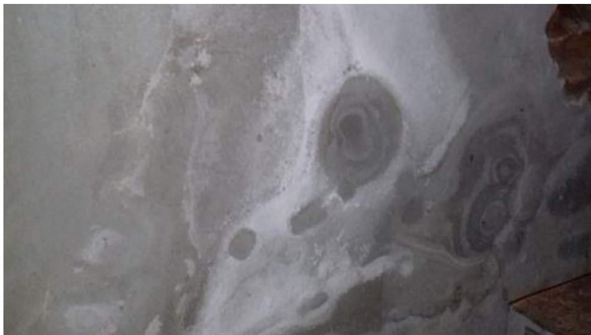
Wykwity solne na ścianie wewnętrznej w piwnicy.
