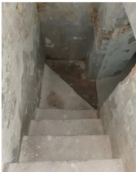
Fotografia 6 i 7 - Schody do piwnicy z ostatnim stopniem zabiegowym(po lewej), ściana z pustym otworem drzwiowym dzielącym pomieszczenie P1 na dwie części -1.2 i -1.3 (po prawej)
