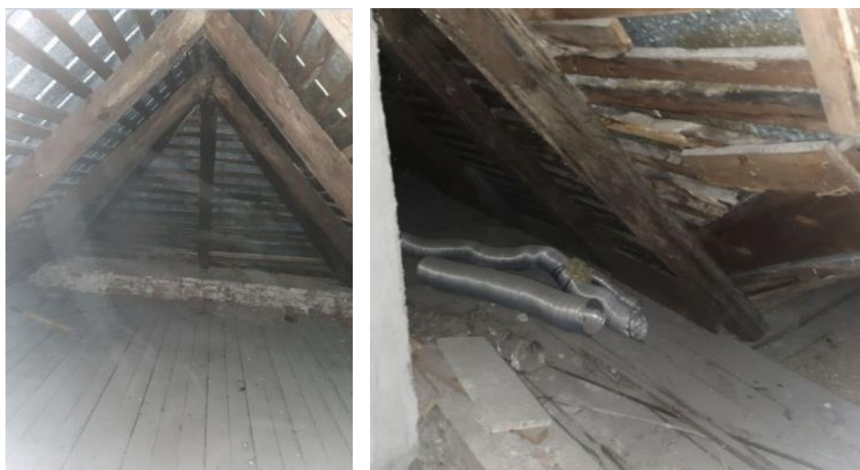
Ilustracja 58. Po lewej: południowa część poddasza - naczółkowe ścięcie południowego szczytu elewacji, po prawej: połączenie dachu głównego z dachem nad zachodnią facjatką, widoczna korozja pokrycia dachowego oraz drewna, źródło: własne
