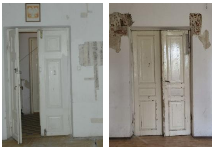
Ilustracja 62. W pomieszczeniach A i B dwuskrzydłowe XIX wieczne drzwi płycinowe (3 pary). Drzwi z holu do pomieszczeń A i B (po lewej) o odmiennej formie i sposobie osadzenia w ścianie niż drzwi z sali B do toalet (po prawej), źródło: własne
