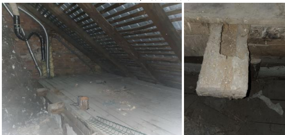
Ilustracja 59. Północna część poddasza. Po lewej: podwyższenie stropu nad помещением G, po prawej - zakończenie belki stropowej nad помещением G, źródło: własne
