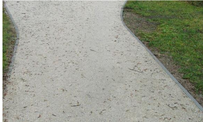
Ilustracja 2 Przykładowa nawierzchnia mineralna, wodoprzepuszczalna
