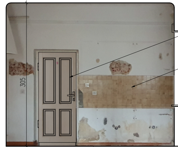
POMIESZCZENIE C ŚCIANA PÓLNOCNA (a)
