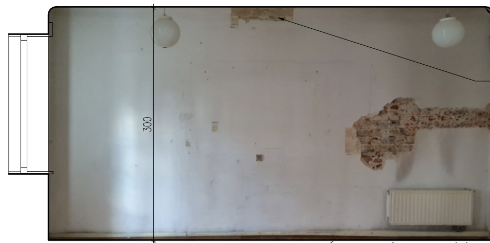
POMIESZCZENIE B ŚCIANA PÓŁNOCNA (a)
