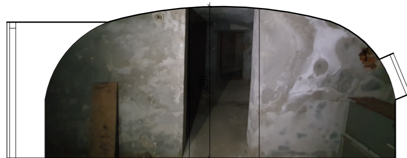
POMIESZCZENIE P1, ŚCIANA DZIAŁOWA PN (e)
