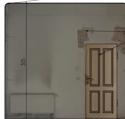
POMIESZCZENIE K ŚCIANA POŁUDNIOWA (f)
