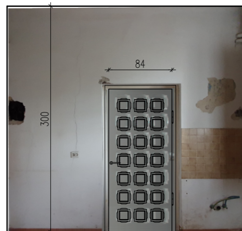
POMIESZCZENIE K ŚCIANA PÓŁNOCNA (e)
