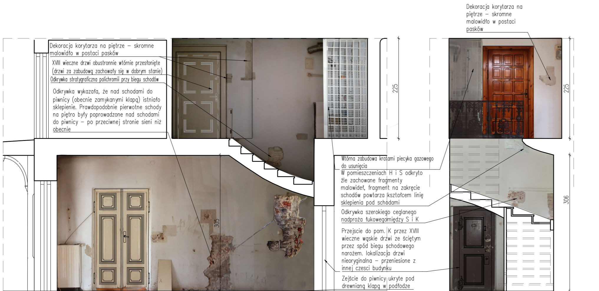
KLATKA SCHODOWA – H i S ŚCIANA PÓŁNOCNA (a)
