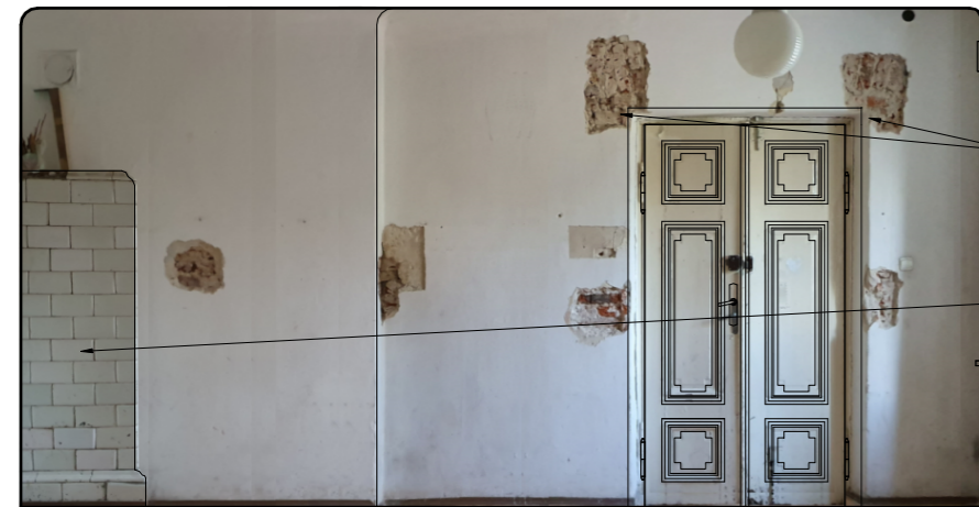
POMIESZCZENIE B ŚCIANA POŁUDNIOWA (b)
