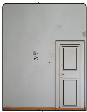
POMIESZCZENIE G ŚCIANA POŁUDNIOWA (b)
