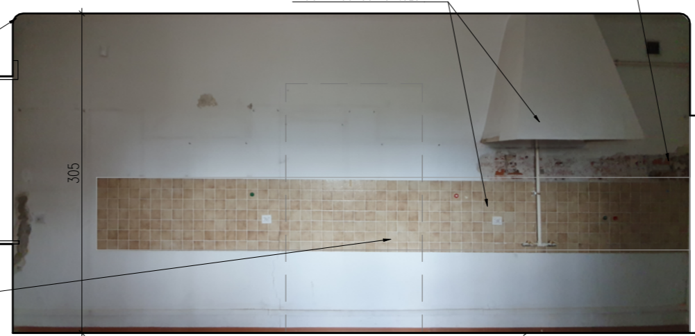
POMIESZCZENIE C ŚCIANA ZACHODNIA (d)
