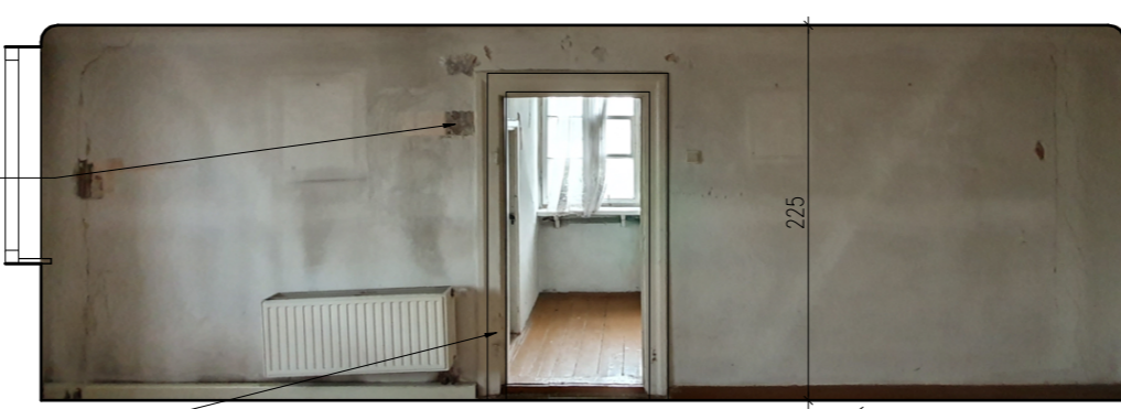
POMIESZCZENIE D ŚCIANA ZACHODNIA
