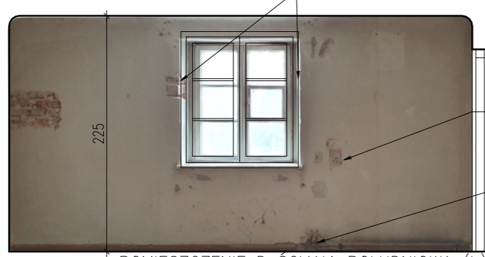
POMIESZCZENIE D ŚCIANA POŁUDNIOWA (b)
