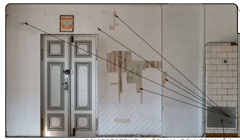
POMIESZCZENIE A ŚCIANA PÓŁNOCNA (a)
