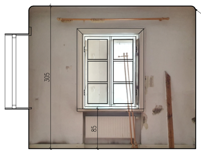
POMIESZCZENIE C ŚCIANA POŁUDNIOWA (b)
