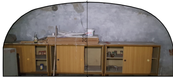
POMIESZCZENIE P1, ŚCIANA PÓŁNOCNA (a)
