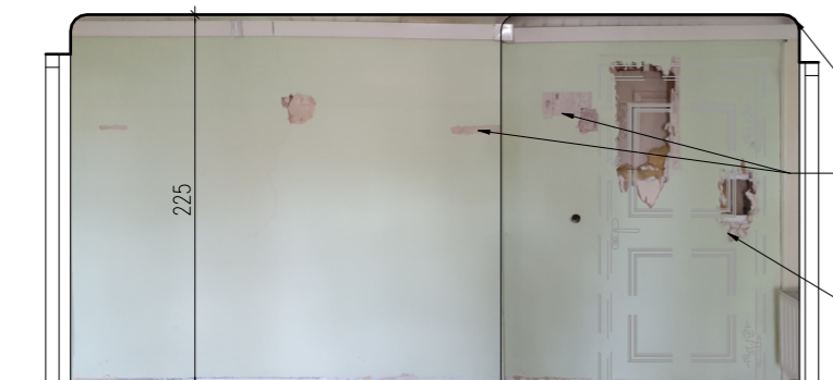
POMIESZCZENIE E ŚCIANA POŁUDNIOWA (b)
