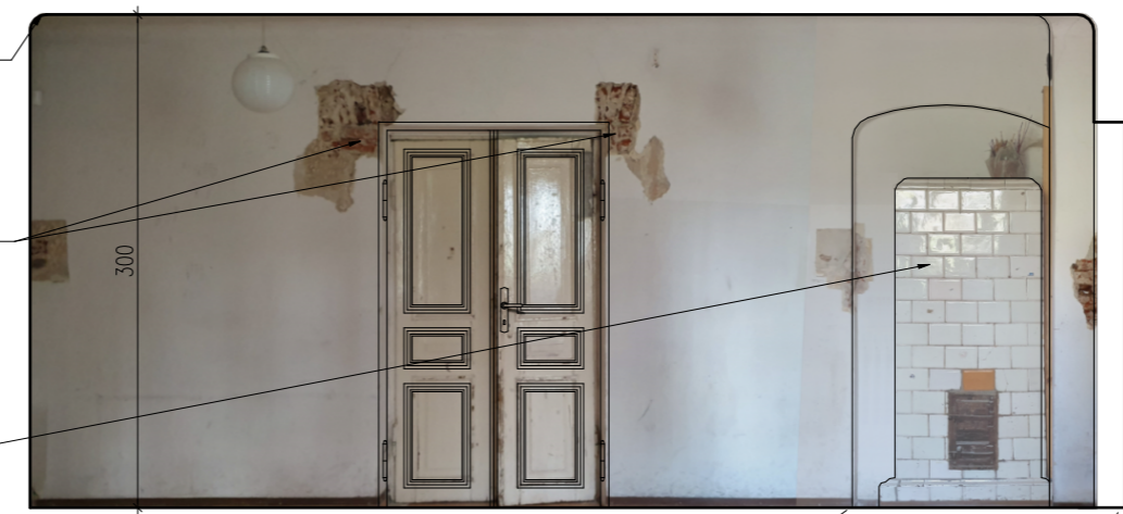
POMIESZCZENIE B ŚCIANA WSCHODNIA (c)
