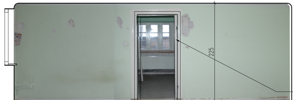
POMIESZCZENIE E ŚCIANA WSCHODNIA (c)
