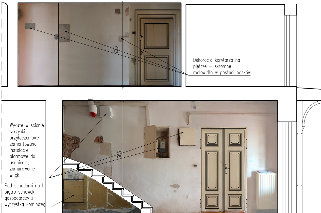
KLATKA SCHODOWA – H i S ŚCIANA POŁUDNIOWA (b)
