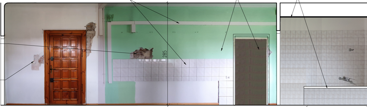
POMIESZCZENIE G ŚCIANA ZACHODNIA (d)
