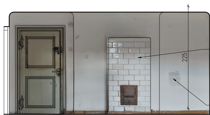
POMIESZCZENIE D ŚCIANA PÓŁNOCNA (a)
