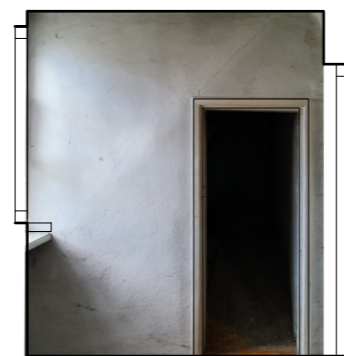
LUKARNA D a ŚCIANA PÓŁNOCNA (a)
