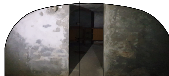
POMIESZCZENIE P1, ŚCIANA DZIAŁOWA PŁD (f)
