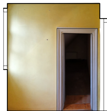
LUKARNA E a ŚCIANA PÓŁNOCNA (a)
