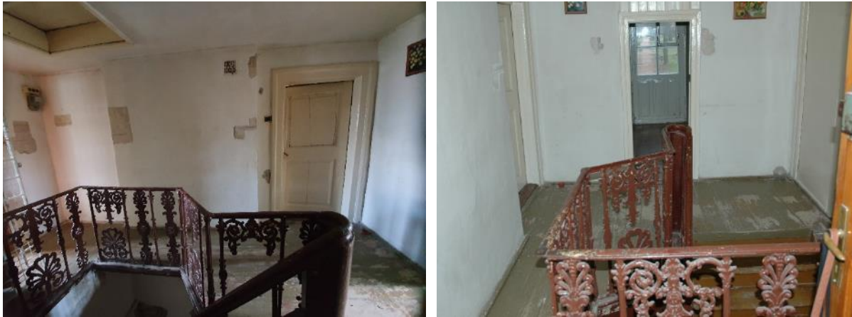
Fotografia 12 i 13 - Obejście schodów na I piętrze. Widok z zakończenia biegu schodowego (po lewej) i z obejścia w kierunku spocznika (po prawej)
