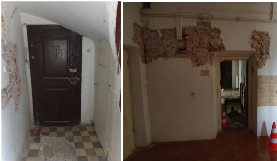
Fotografia 10 i 11 - Zniżenie wysokości przejścia w holu głównym pod biegiem schodowym na pierwsze piętro (po lewej) i zarys szerokiego odcinkowego nadproża widoczny od strony pomieszczenia K – projektowanego holu przed toaletą (po prawej).
