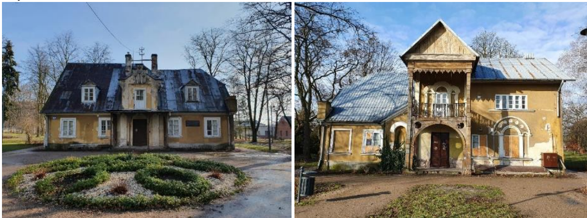
Fotografia nr 1 i nr 2 - Elewacje zachodnia (po lewej) i wschodnia (po prawej) budynku Poniatówki w Parku Miejskim w Piasecznie
