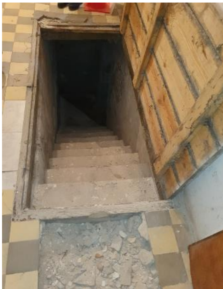
Fotografia 4 i 5 - Schody do piwnicy zamykane klapą w podłodze (po lewej), wejście na schody z poziomu piwnicy (po prawej)
