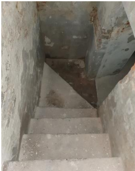
Fotografia 6 i 7 - Schody do piwnicy z ostatnim stopniem zabiegowym(po lewej), ściana z pustym otworem drzwiowym dzieląca pomieszczenie P1 na dwie części -1.2 i -1.3 (po prawej)
