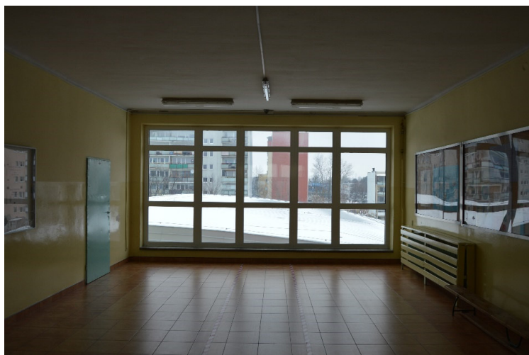
Fot. 21. Otwór okienny podlegający zabezpieczeniu balustradą do wysokości h=85\text{cm} .
