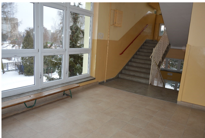
Fot. 15. Otwór okienny na piętrze I podlegający zabezpieczeniu balustradą do wysokości h=85\text{cm} , balustrada schodowa podlegająca oczyszczeniu oraz malowaniu.
