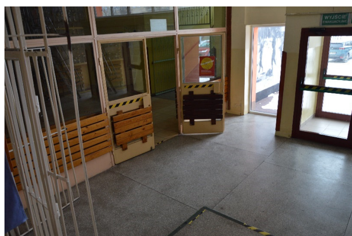
Fot. 4. Szklano-aluminiowa zabudowa drzwiowa przeznaczona do demontażu
