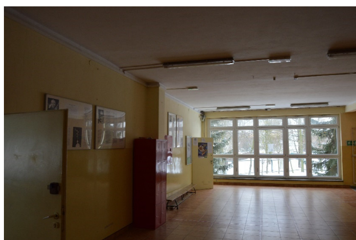
Fot. 5. Otwór okienny podlegający zabezpieczeniu balustradą do wysokości h=85\text{cm} .
