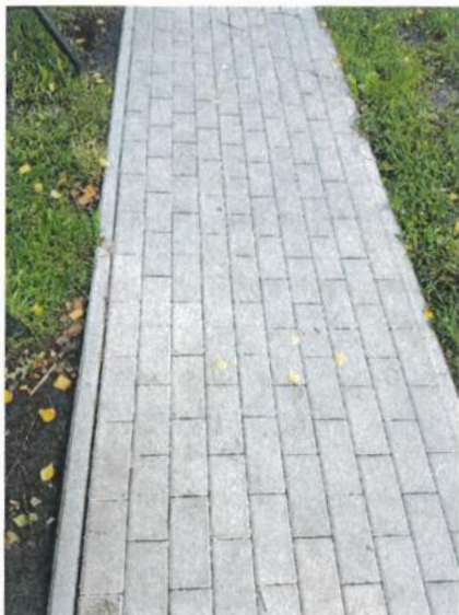
Nawierzchnia istniejąca stan 11.08.2021.
