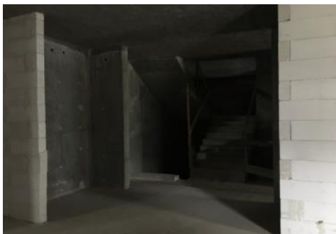
Ilustracja: Wnętrze przyszłej siedziby głównej
