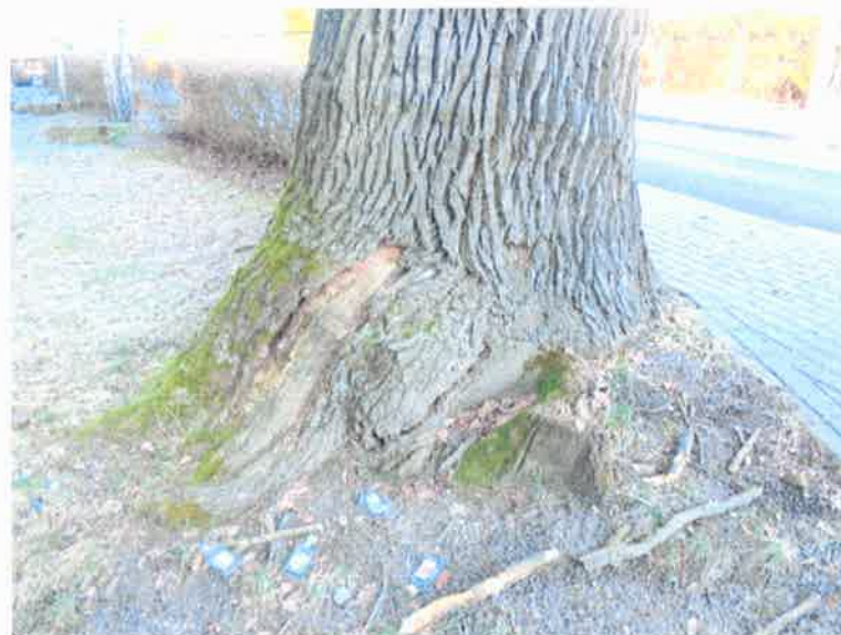
Fot. Warunki rozwoju korzeni, uszkodzenia odziomka
