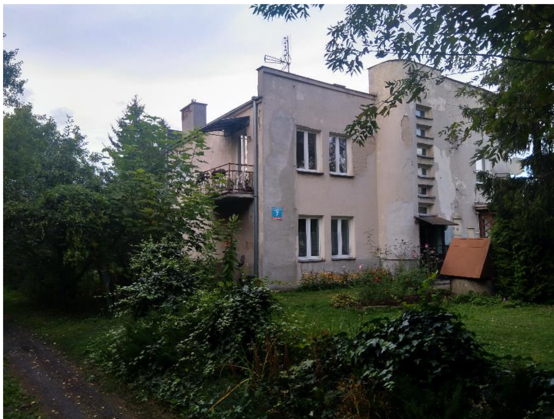
Km 0+430 – budynek zabytkowy
