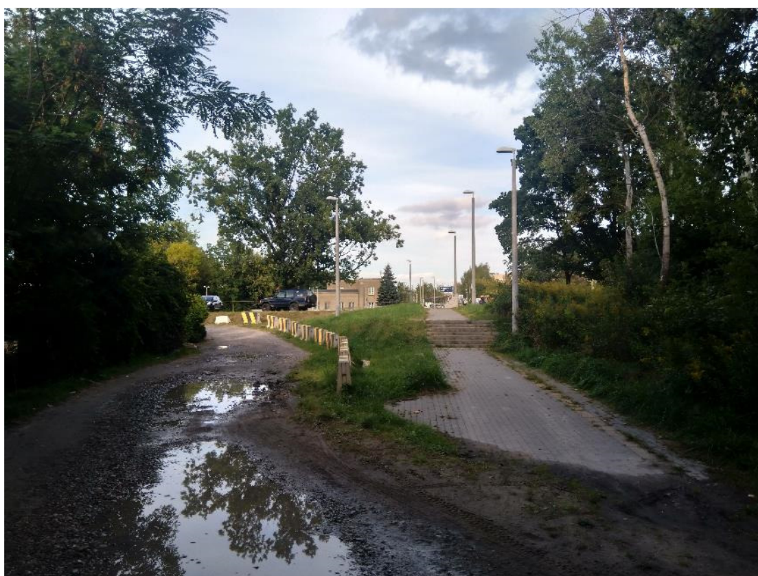
Km 0+750 – widok kolei
