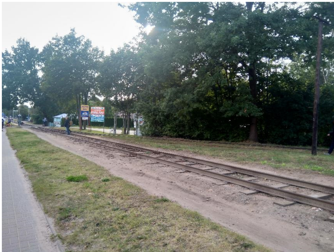
Tory kolei wąskotorowej w miejscu projektowanego ronda
