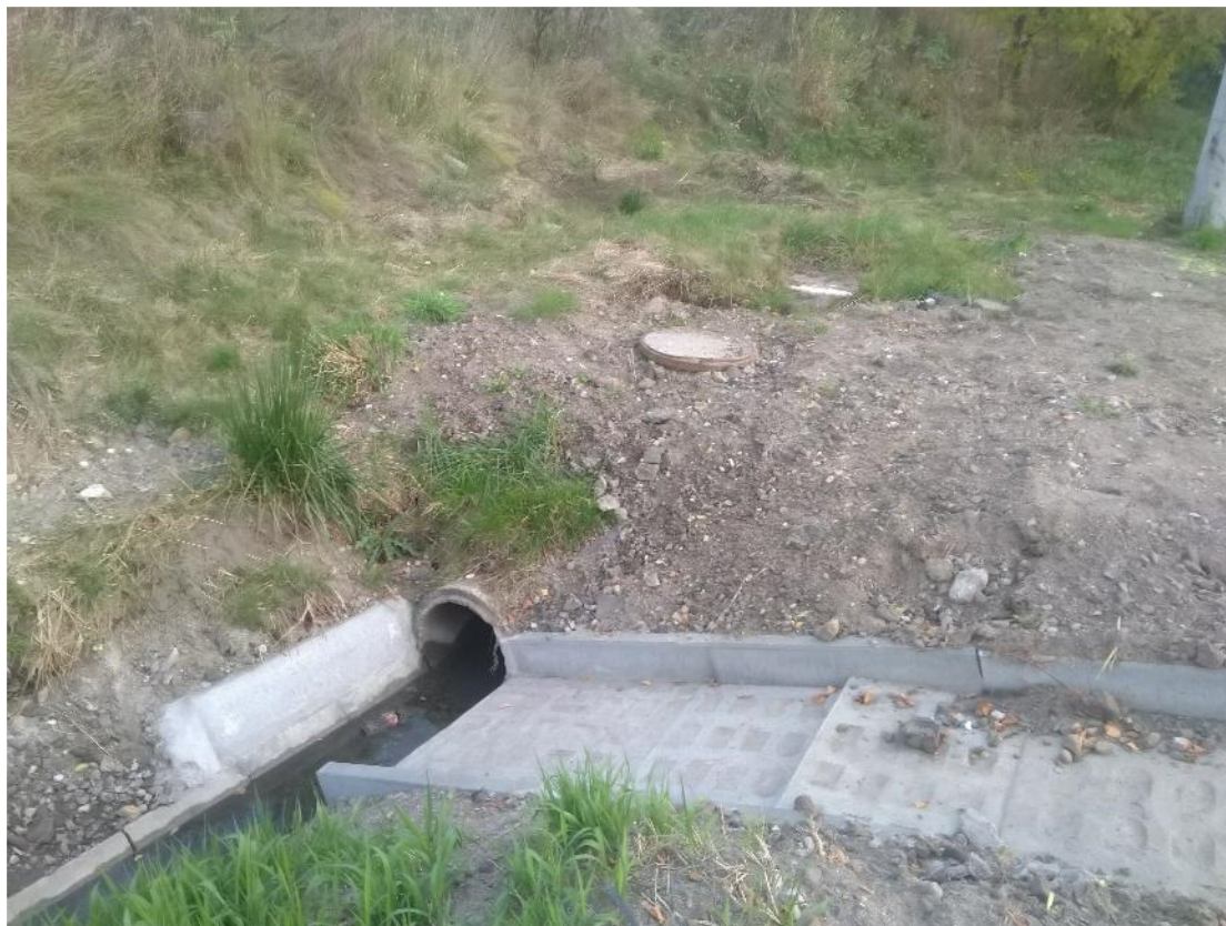
Początek opracowania – wylot kanalizacji deszczowej do rowu kolejowego
