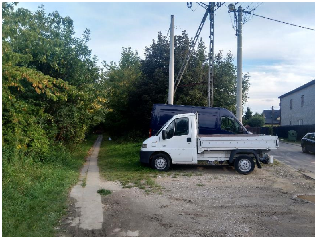
Km 0+560 – widok w kierunku ul. Sienkiewicza
