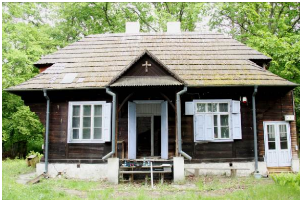
Widok elewacji zachodniej w stanie istniejącym
