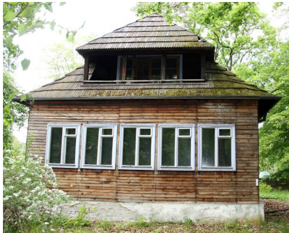
Widok elewacji południowej w stanie istniejącym
