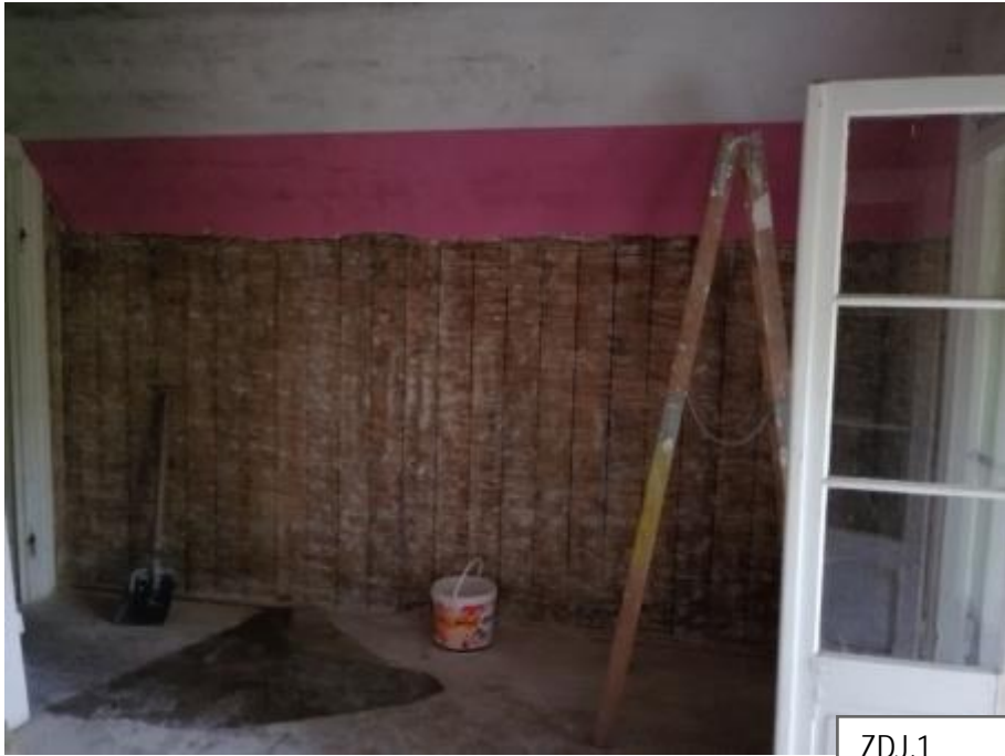
Zdjęcie nr 1 Ściana zachodnia pom. 204 po usunięciu tynku.
