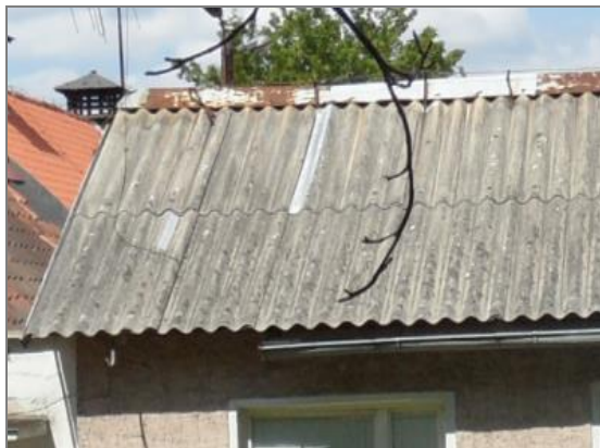
Fot.1 Płyty azbestowo-cementowe faliste
