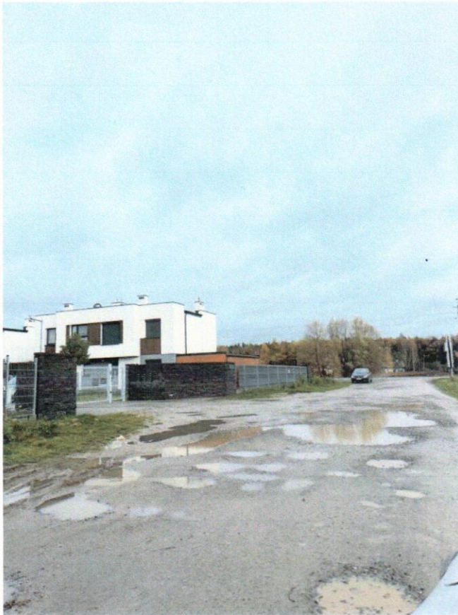
Zdjęcie nr 9 – Stan drogi z dnia 14 listopada 2023 roku
