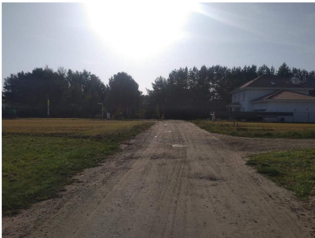
km 0+985 widok w kierunku ul. Bobrowieckiej
