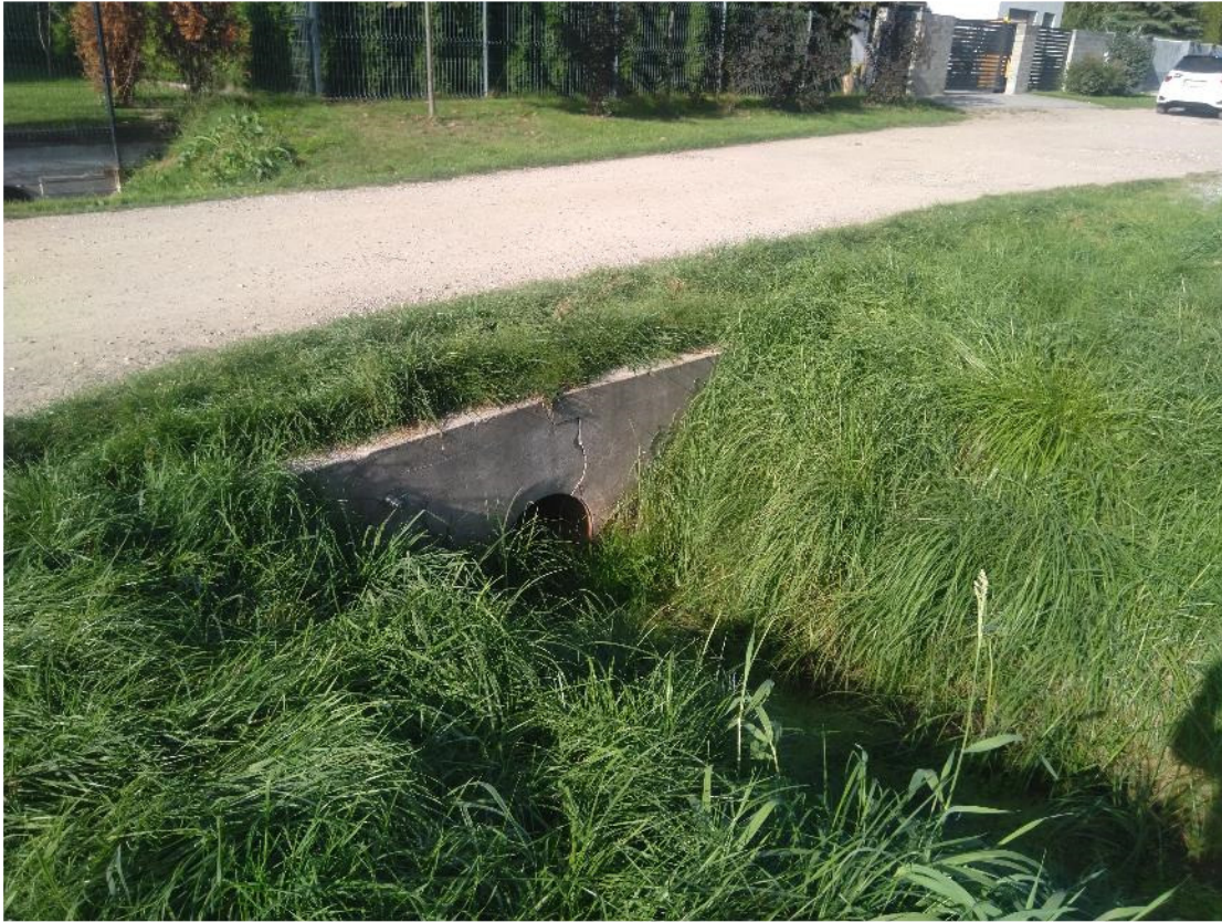
km 0+945 – przepust na rowie melioracyjnym
