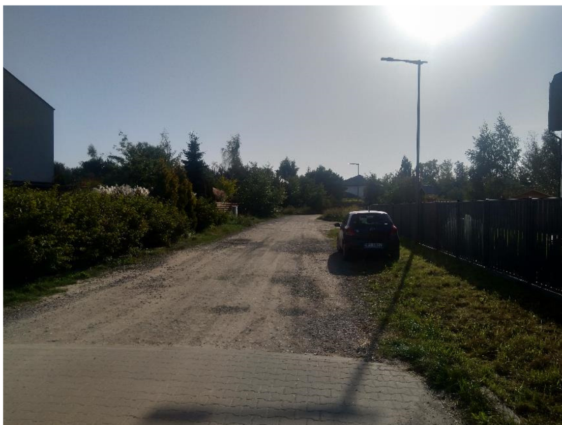
km 0+110 widok w kierunku ul. Bobrowieckiej
