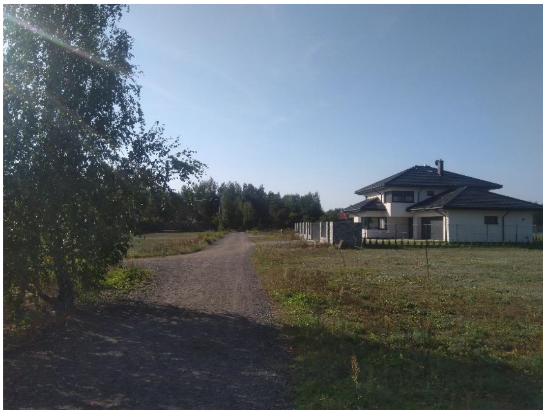
km 0+410 widok w kierunku ul. Bobrowieckiej
