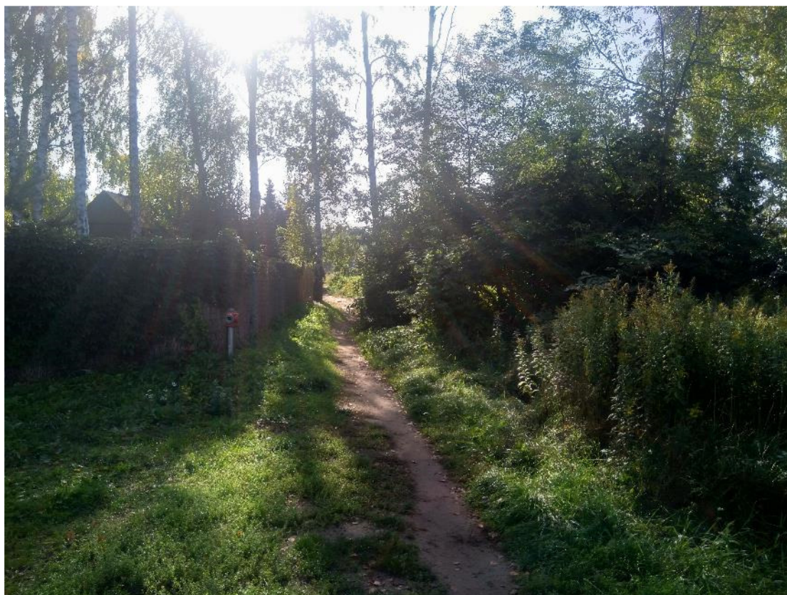
km 0+320 widok w kierunku ul. Bobrowieckiej
