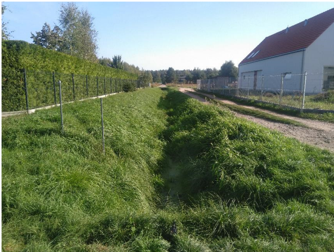
km 0+945 – rów melioracyjny widok w kierunku wschodnim
