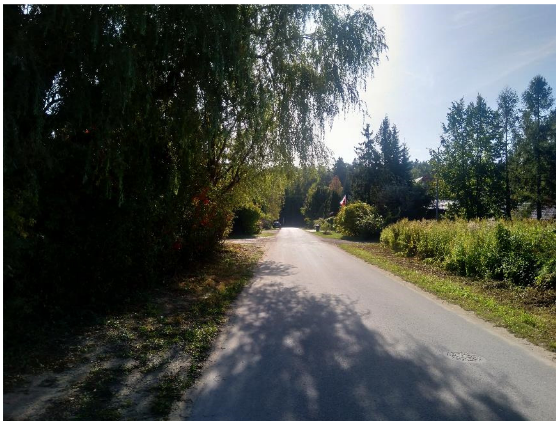
km 1+410 widok w kierunku ul. Bobrowieckiej
