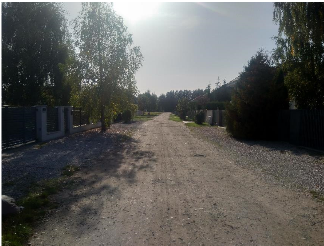
km 0+850 widok w kierunku ul. Bobrowieckiej
