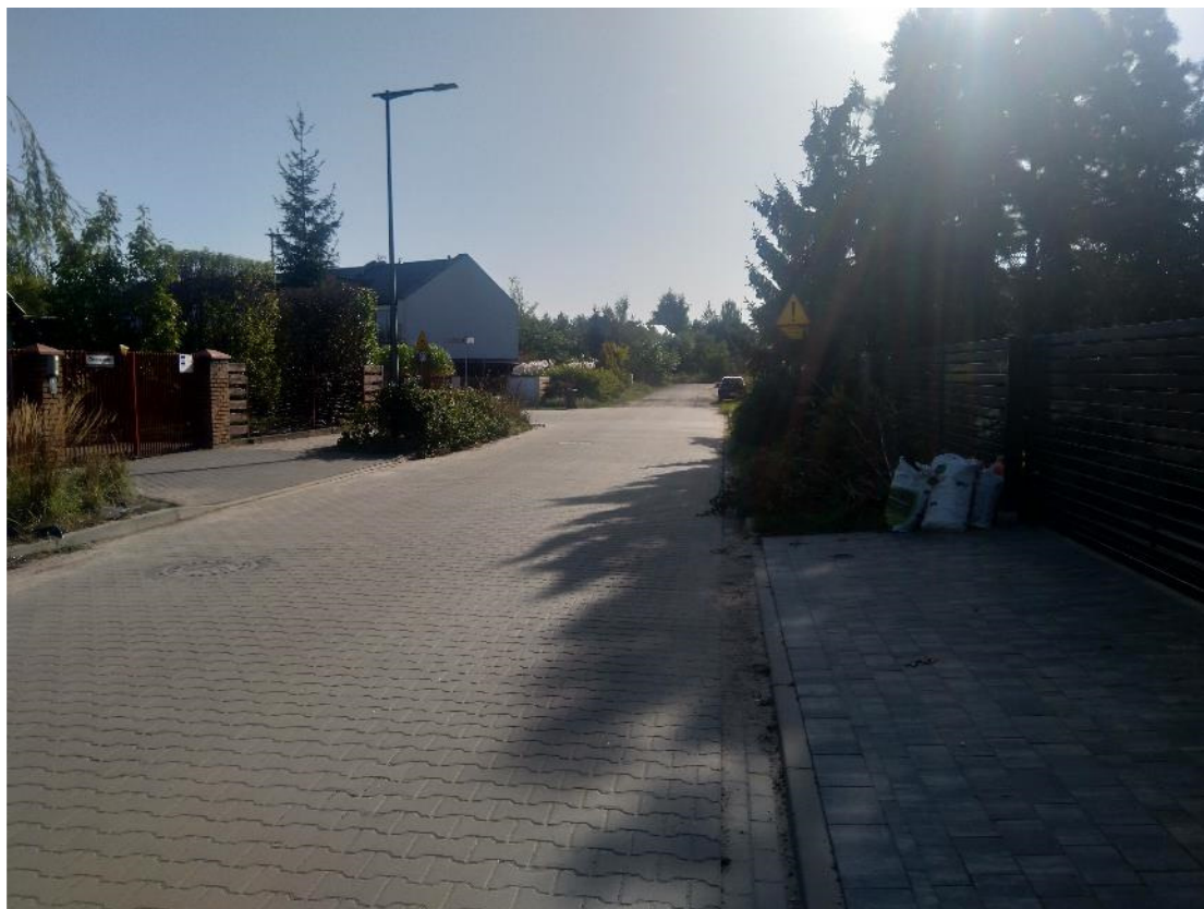
km 0+075 widok w kierunku skrzyżowania z ul. Skalną
