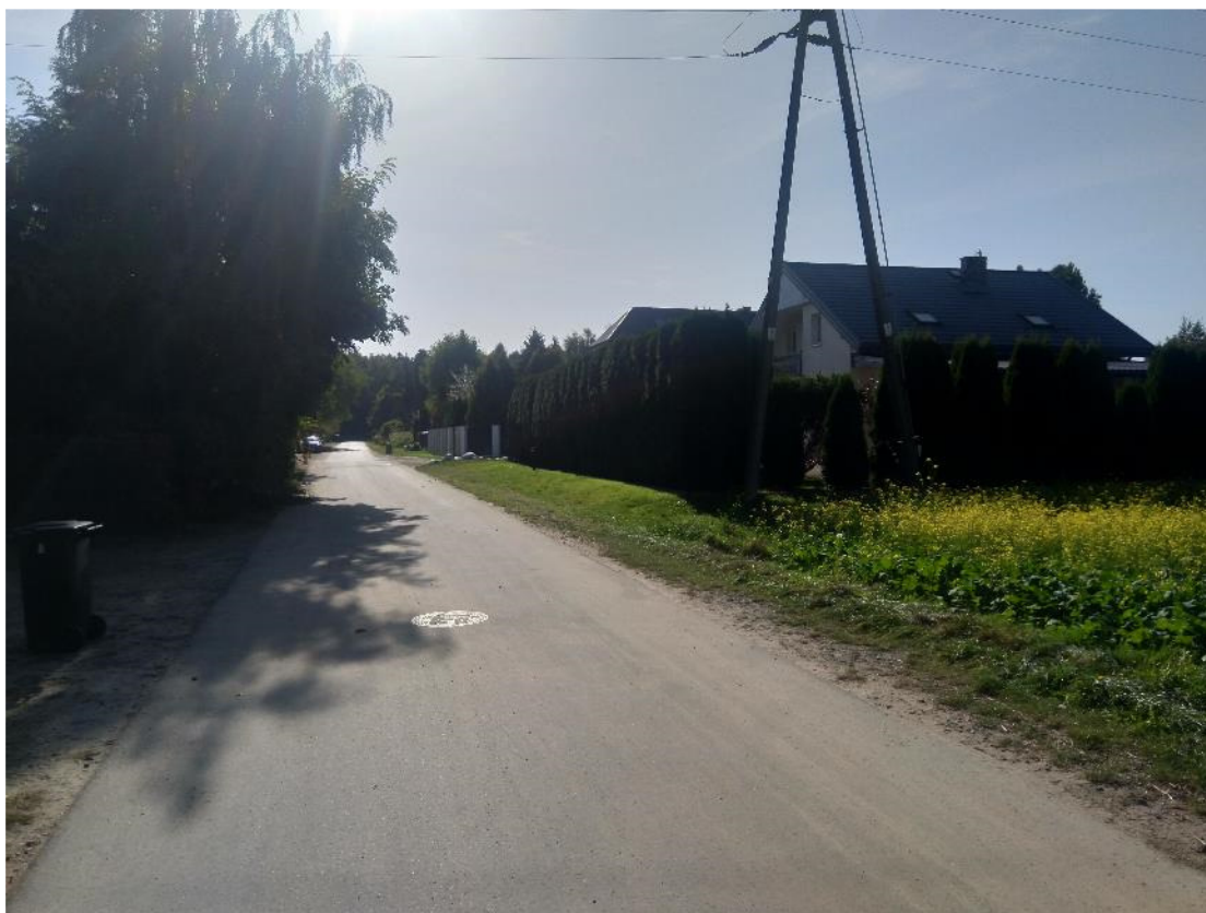
km 1+300 widok w kierunku ul. Bobrowieckiej
