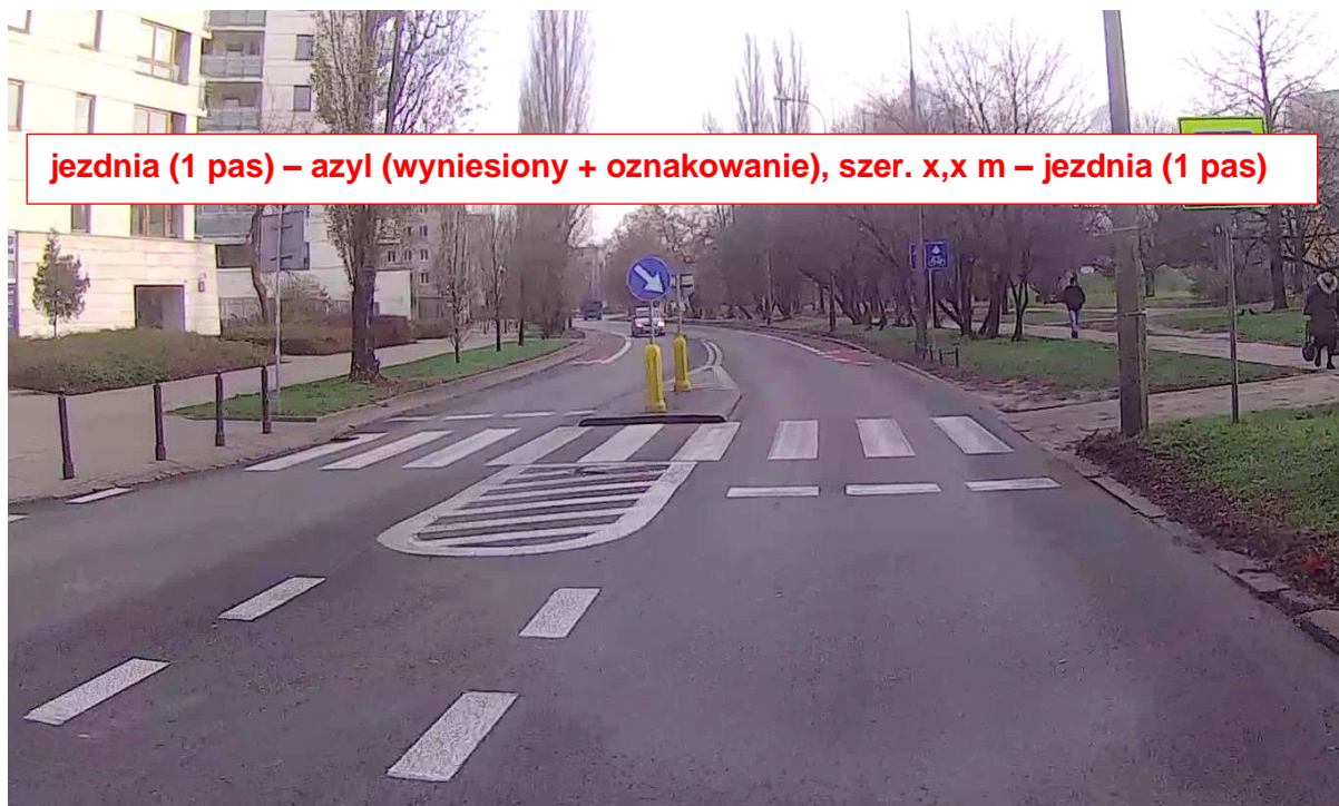
Rys. 2.14 Elementy przekroju poprzecznego – przykład I.
