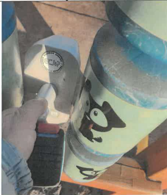
Naturalne wytarcie i zużycie powierzchni podestów. Na dzień inspekcji nie stanowi zagrożenia. Należy podjąć monitorowanie podestów.
