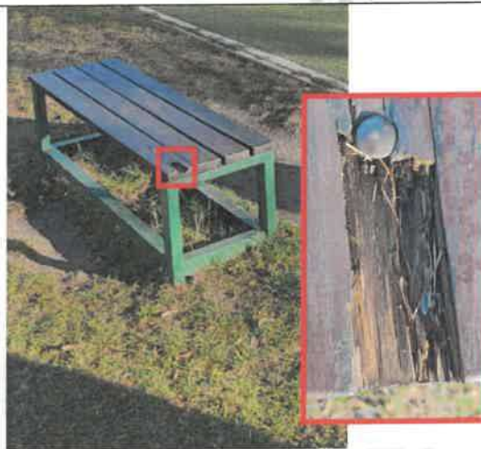
Spróchniała i wyszczerbiona ławka. Należy podjąć działania naprawcze
