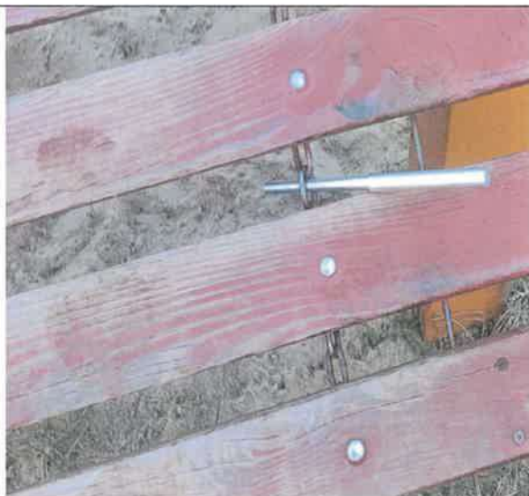
Za duże otwory w ogniwach łańcucha. Należy podjąć działania naprawcze
