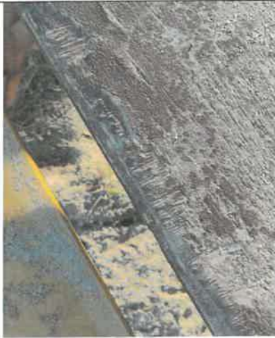
Naturalne wytarcie i zużycie powierzchni podestów. Na dzień inspekcji nie stanowi zagrożenia. Należy podjąć monitorowanie podestów.
