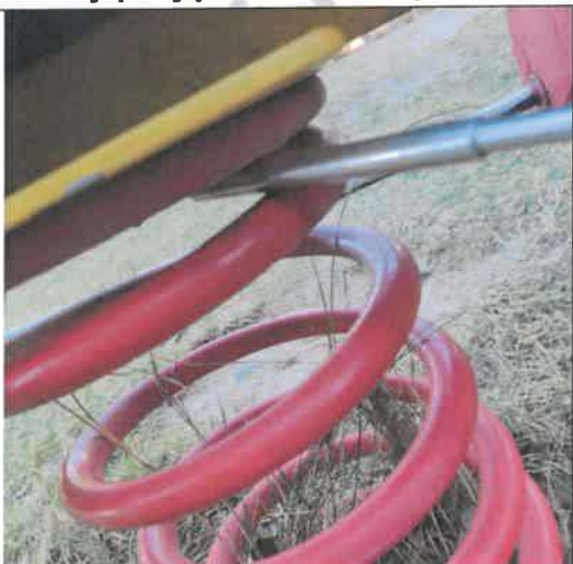
Wystające wkręty i niedokręcone śruby. Należy podjąć działania naprawcze
