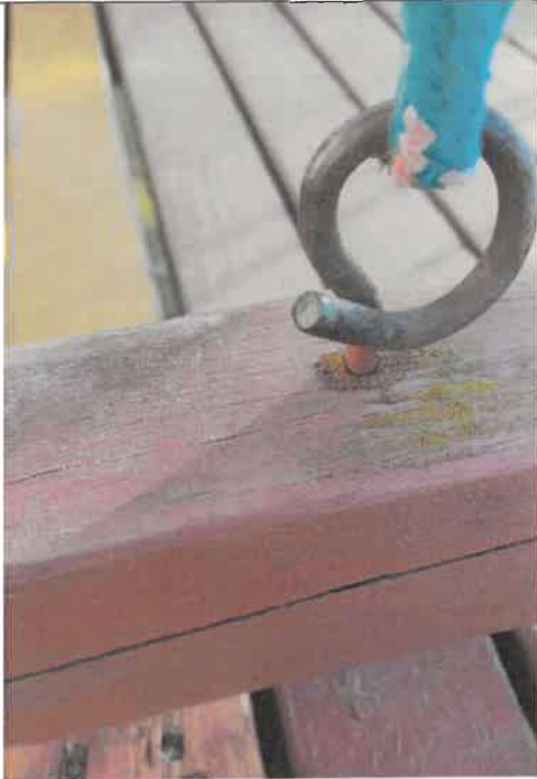
Ostre zakończenia haczyków. Należy podjąć działania naprawcze
