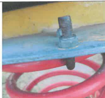
Niezabezpieczone ostre gwinty śrub. Należy podjąć działania naprawcze
