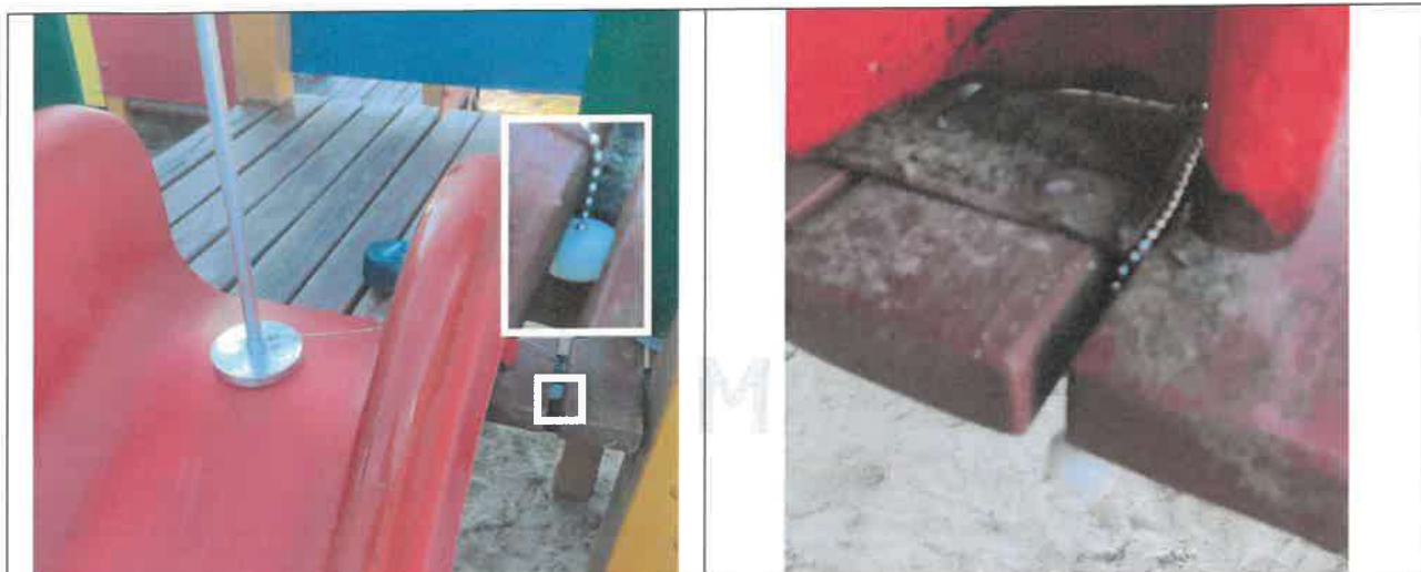
Zakleszczenie guzika w szczelinach podestu. Należy podjąć działania naprawcze.
